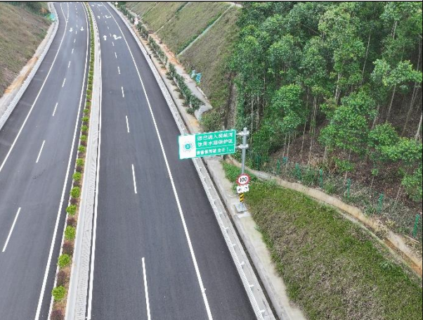
K12+600 左侧设置穿越水源地警示标识及危化品车辆限速标志
