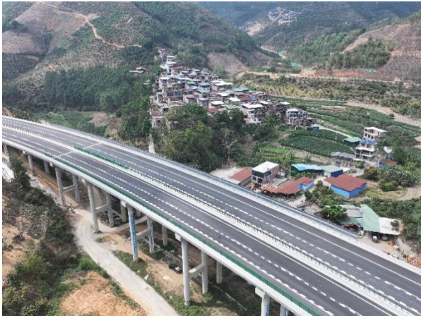
K21+000 外苏 1 号大桥
