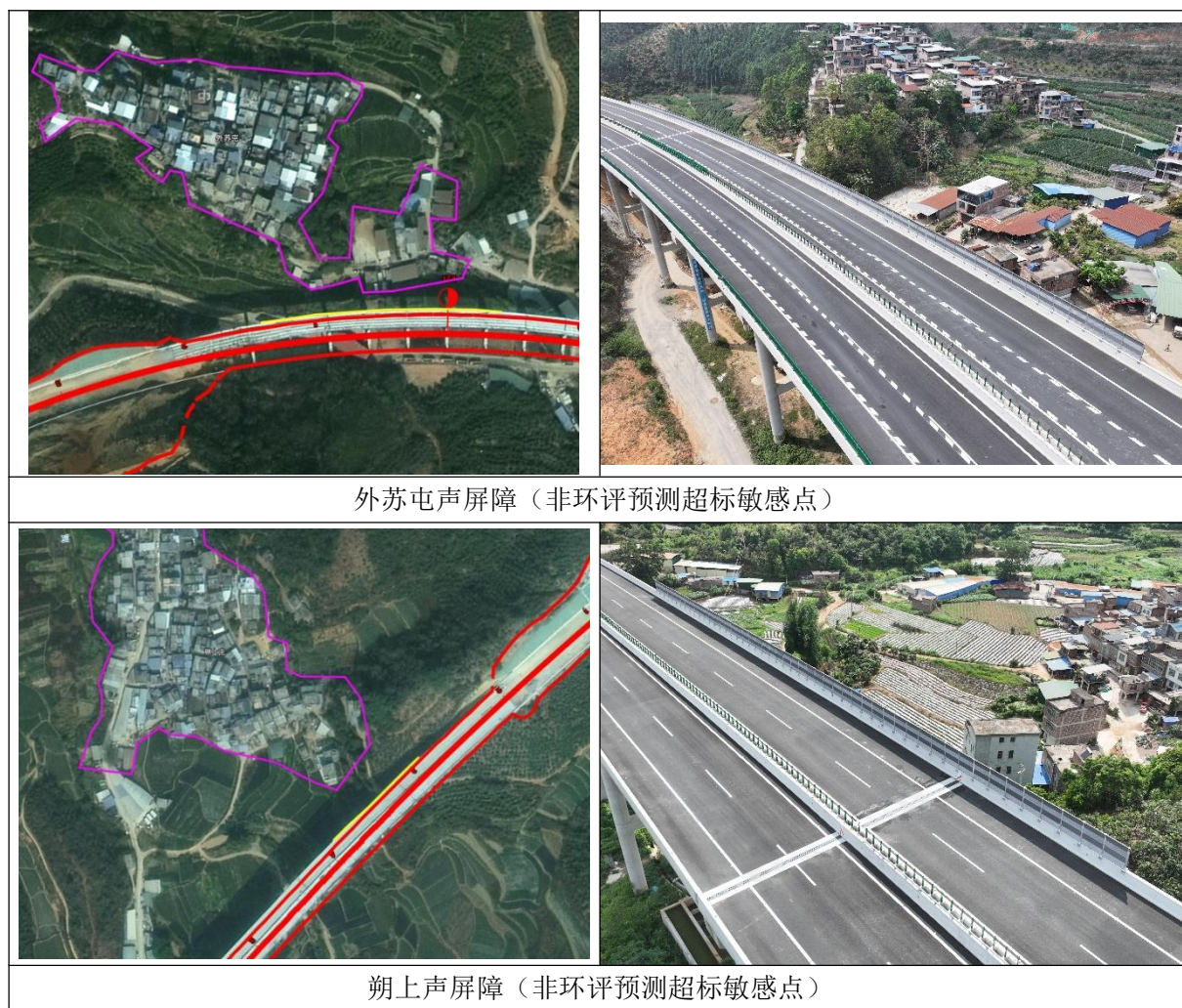
图 6.3-1 本项目建设声屏障设施现状图片
