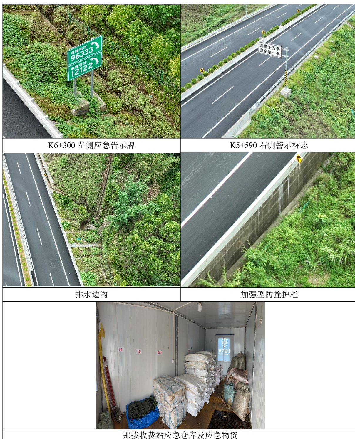
图 8.5-2 项目用地涉及义圩镇符桃村石桃屯那来水源地段风险防范措施现状
