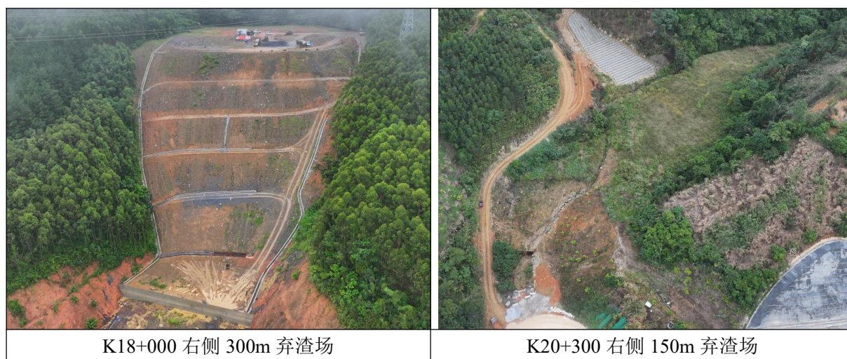
图 9.1-1 本项目典型弃渣场利用现状图
