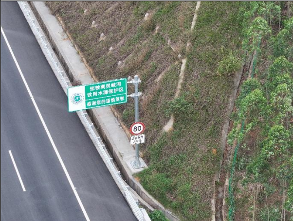
K11+200 右侧设置穿越水源地警示标识及危化品车辆限速标志
