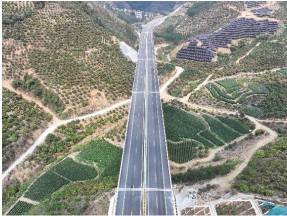
K21+770 外苏 2 号大桥
