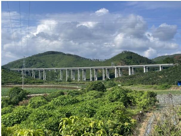
ZK16+042/YK16+105 六联 4 号大桥（拼宽桥）
