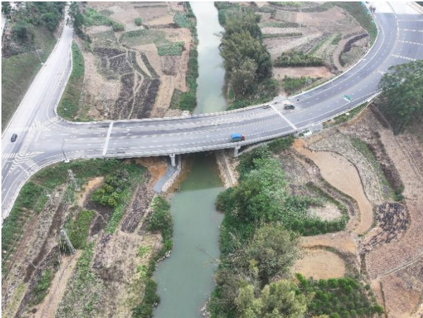
AK0+088 A 匝道桥（灵岐河中桥）
