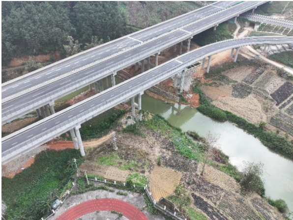
K11+812 六洲大桥及 DK0+400 D 匝道桥
