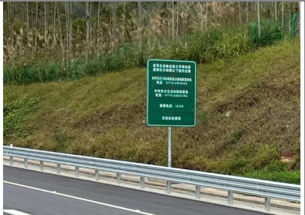
K12+470 右侧环境应急告示牌
