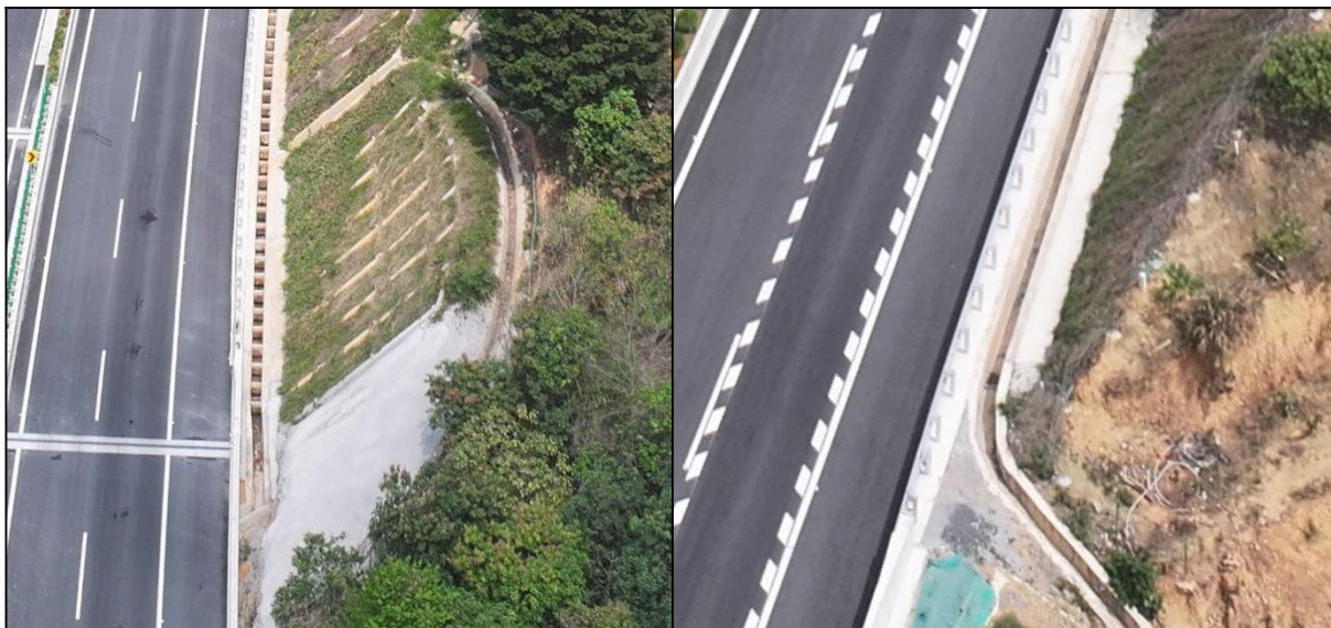
图 5.3-4 典型公路排水设施现状
