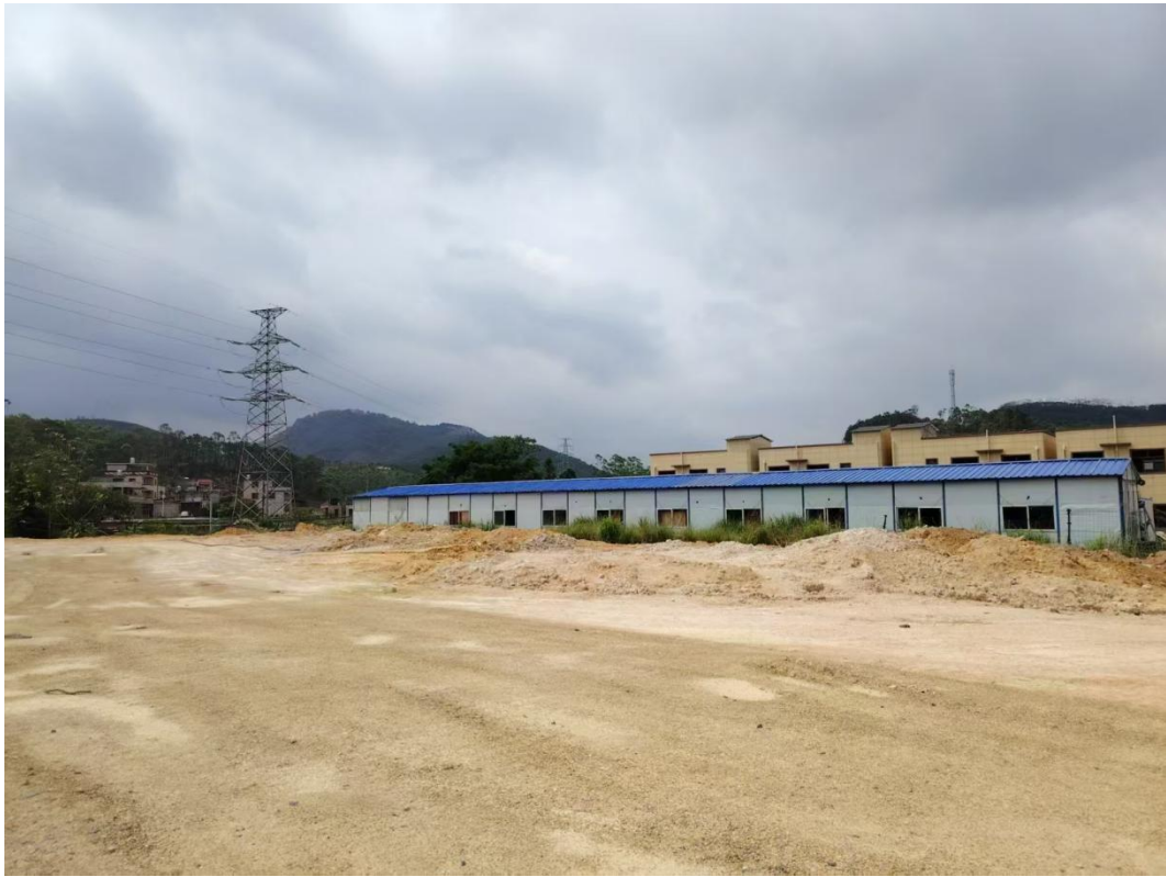
项目区现状照片
