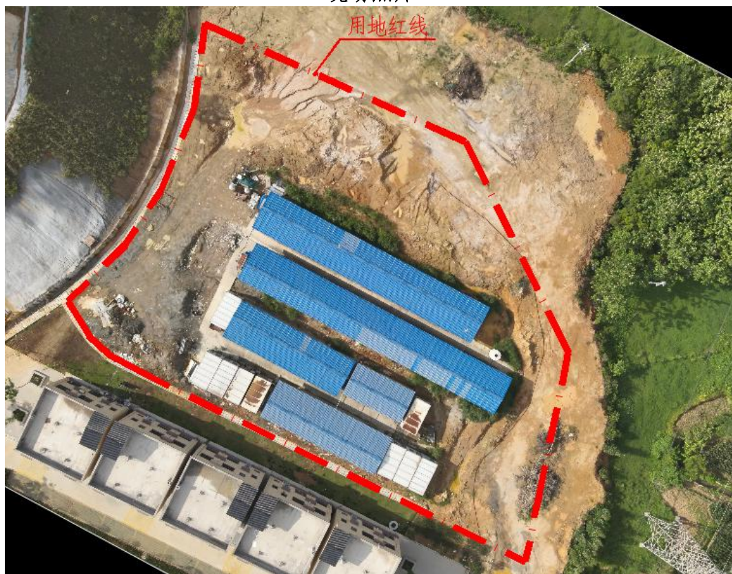
项目区现状照片
