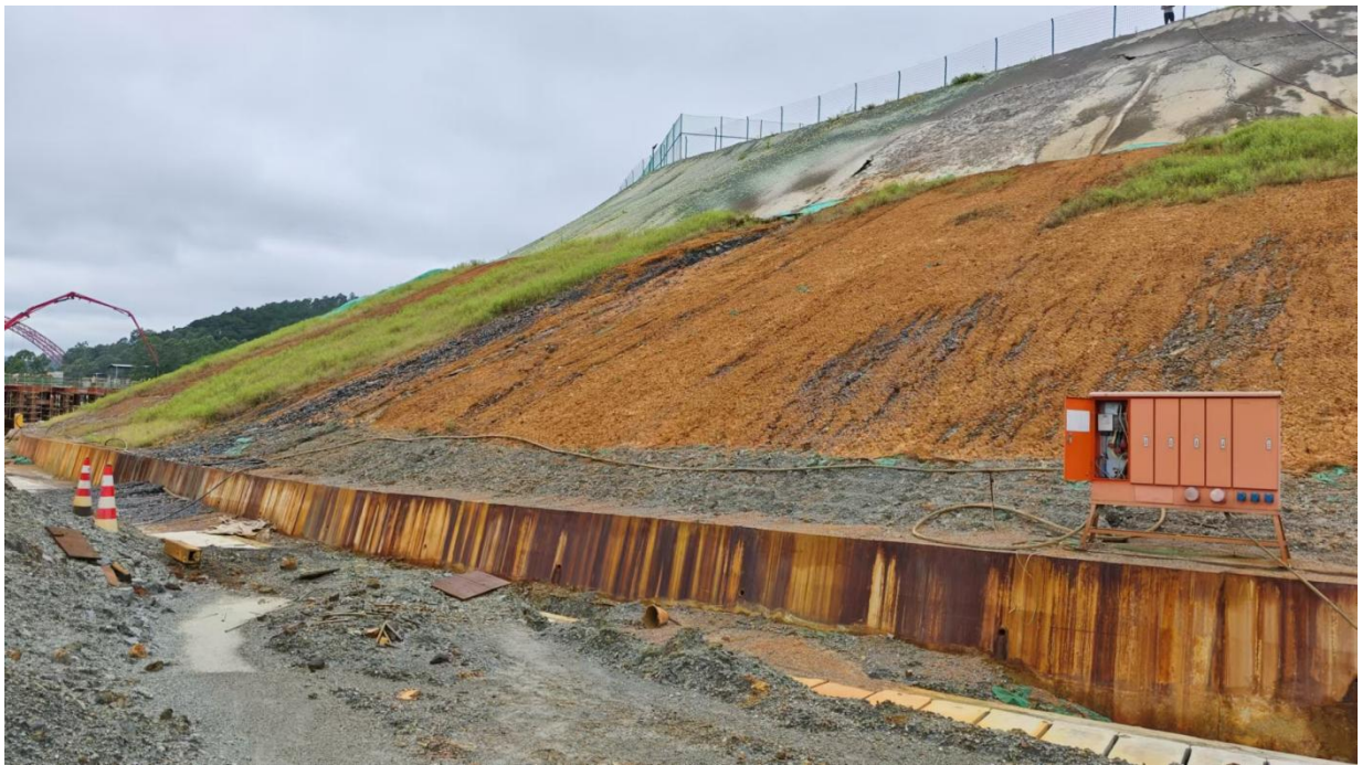
项目西侧护坡现状
