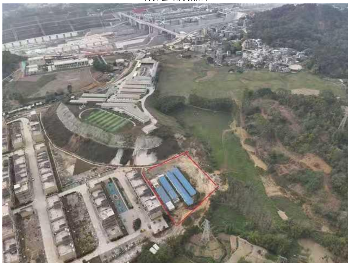
项目区现状照片
