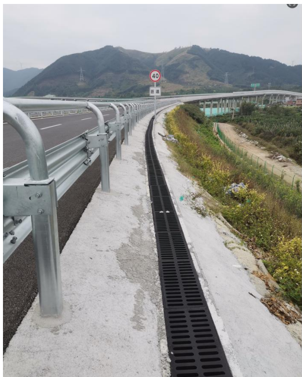
C 匝道路面双排水边沟
