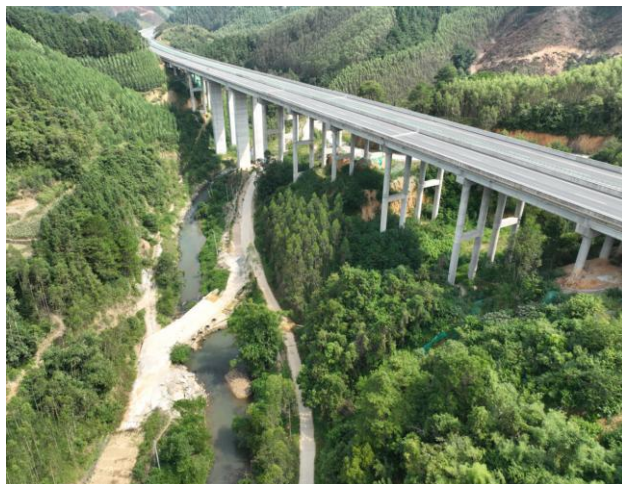
K17+983 深水 3 号大桥
