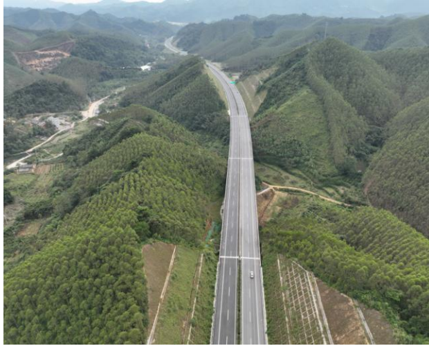
K31+030 和平 2 号大桥
