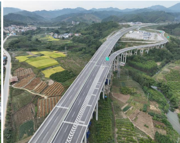
K26+880 陈平互通庙面大桥
