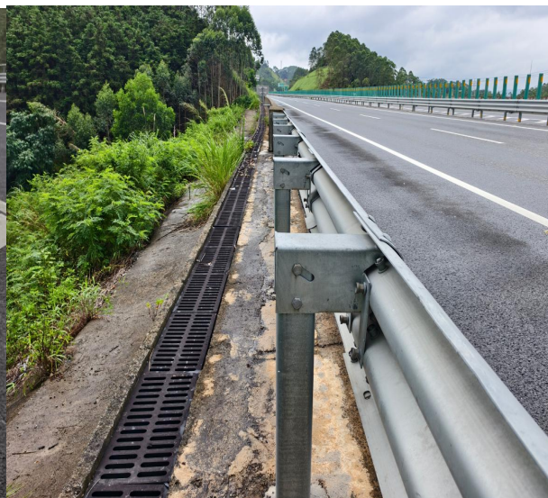
左幅左侧路面双排水沟
