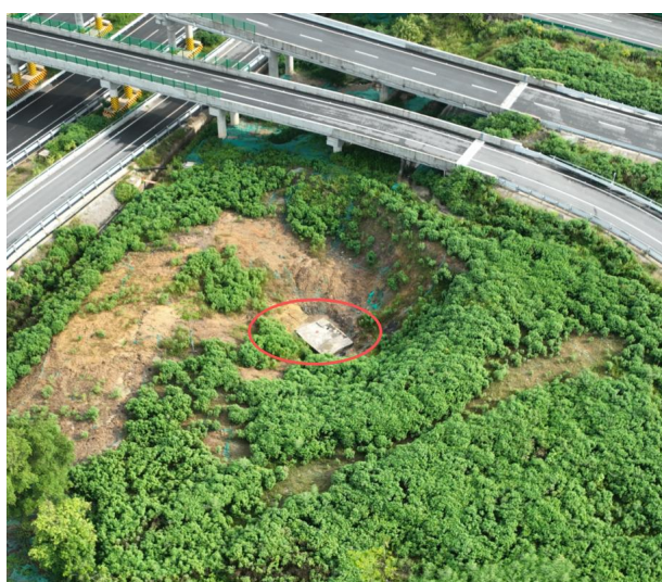
K42+130 左侧沉淀-事故应急池
