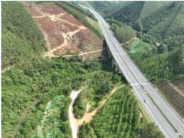
K18+942 耀屋 1 号大桥
