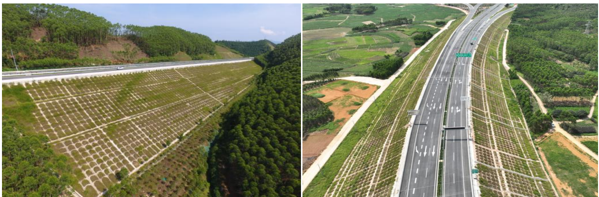
典型填方路段边坡植物防护现状
