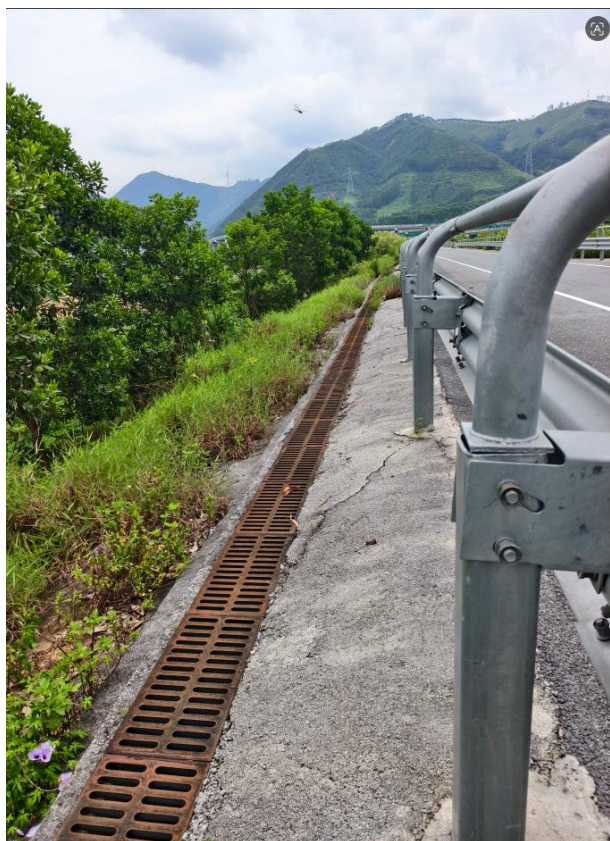
主线右幅右侧设置双排水边沟
