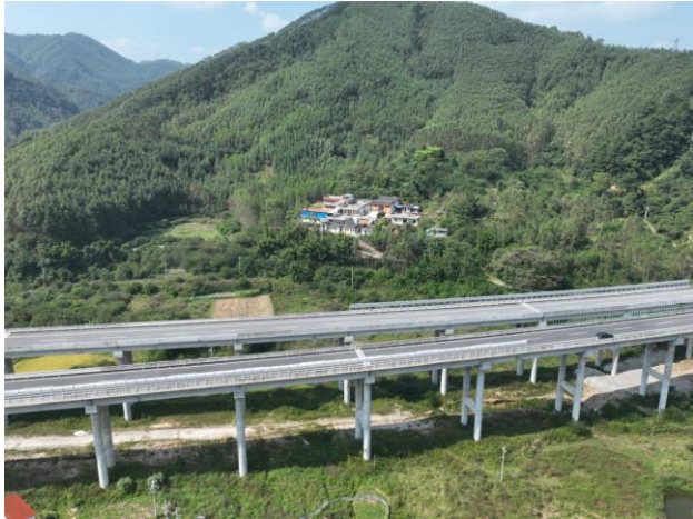
K35+823 新兴大桥
