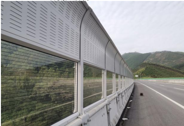
碗窑村陈新屯（ZK35+830~ZK35+950）左侧声屏障
