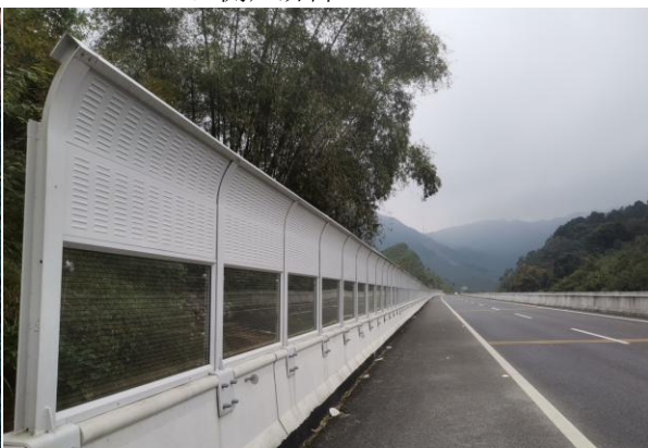
碗窑村碗窑屯（K36+330~K36+670）右侧声屏障
