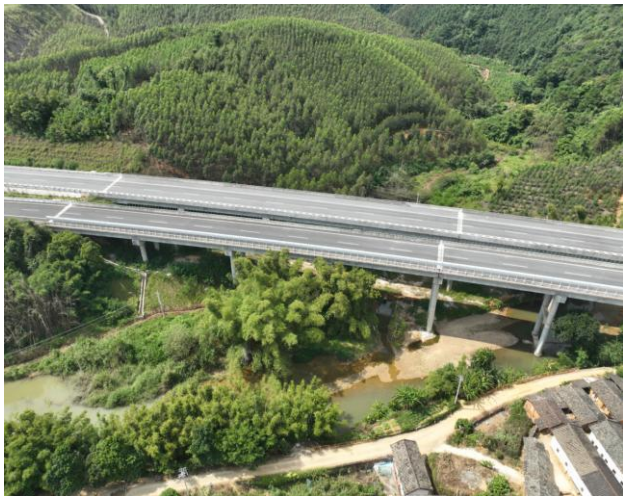
K22+539 金坑 2 号大桥
