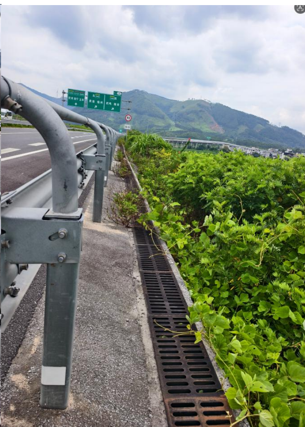
主线左幅右侧双排水边沟
