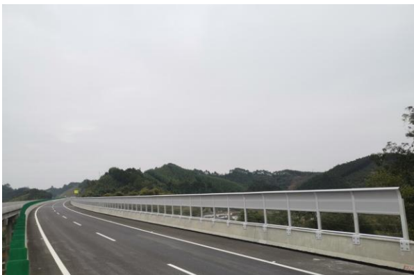
五星村金坑屯（K22+340~K22+580）右侧声屏障
