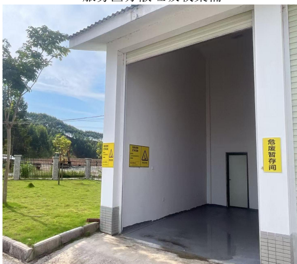
服务区危险废物暂存区
