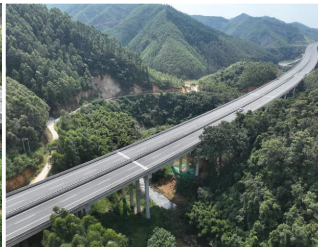
K18+495 深水 4 号大桥
