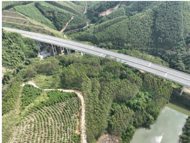
K19+445 耀屋 2 号大桥
