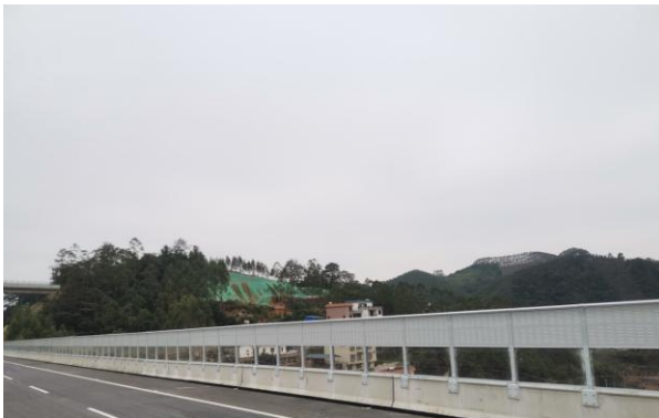
望齐村望齐屯（ZK10+850~ZK11+000）左侧声屏障
