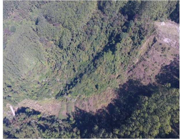
K37+400 左 1.7km 弃渣场
