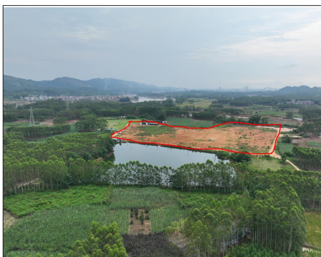
K2+100 左 270m 拌合站及钢筋加工场
