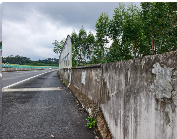
桥梁段加强型防撞护栏（SS 级）
