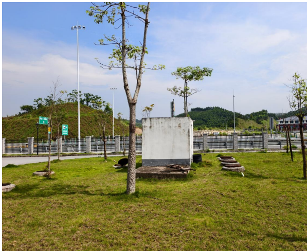
陈平收费站污水处理设施
