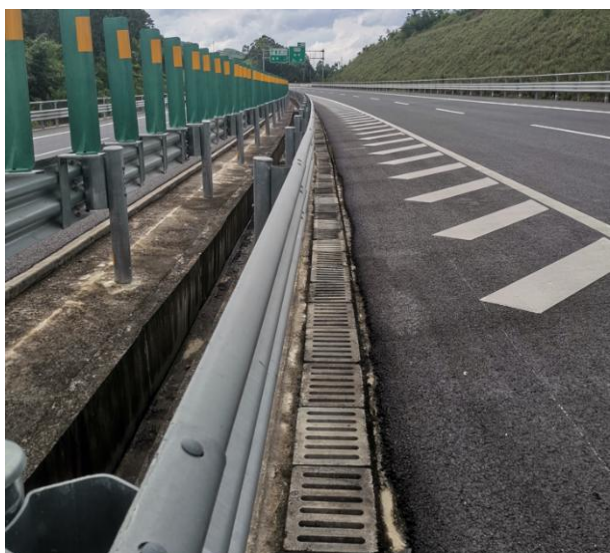
右幅左侧路面双排水沟
