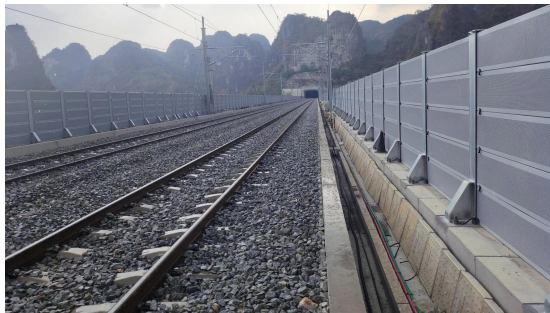
在可能有熊猴、猕猴的 D1K35+850~D1K36+300 路段两侧设置声屏障
