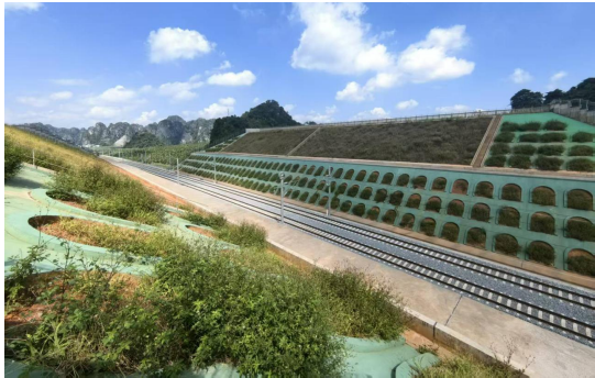
立新隧道改路基段生态修复现场照片
