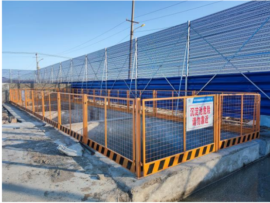
CPZQ1 标施工场界外围设置铁皮进行围挡
