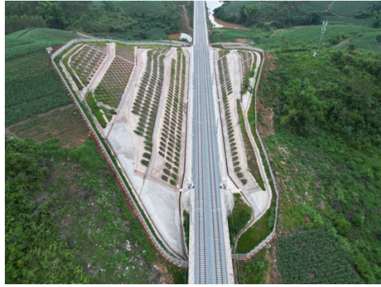
D1K26+500 路基边坡排水、防护系统
