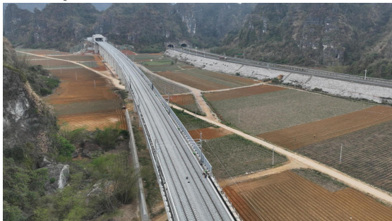
在有熊猴、猕猴的 D1K35+000~D1K35+600 路段两侧设置声屏障
