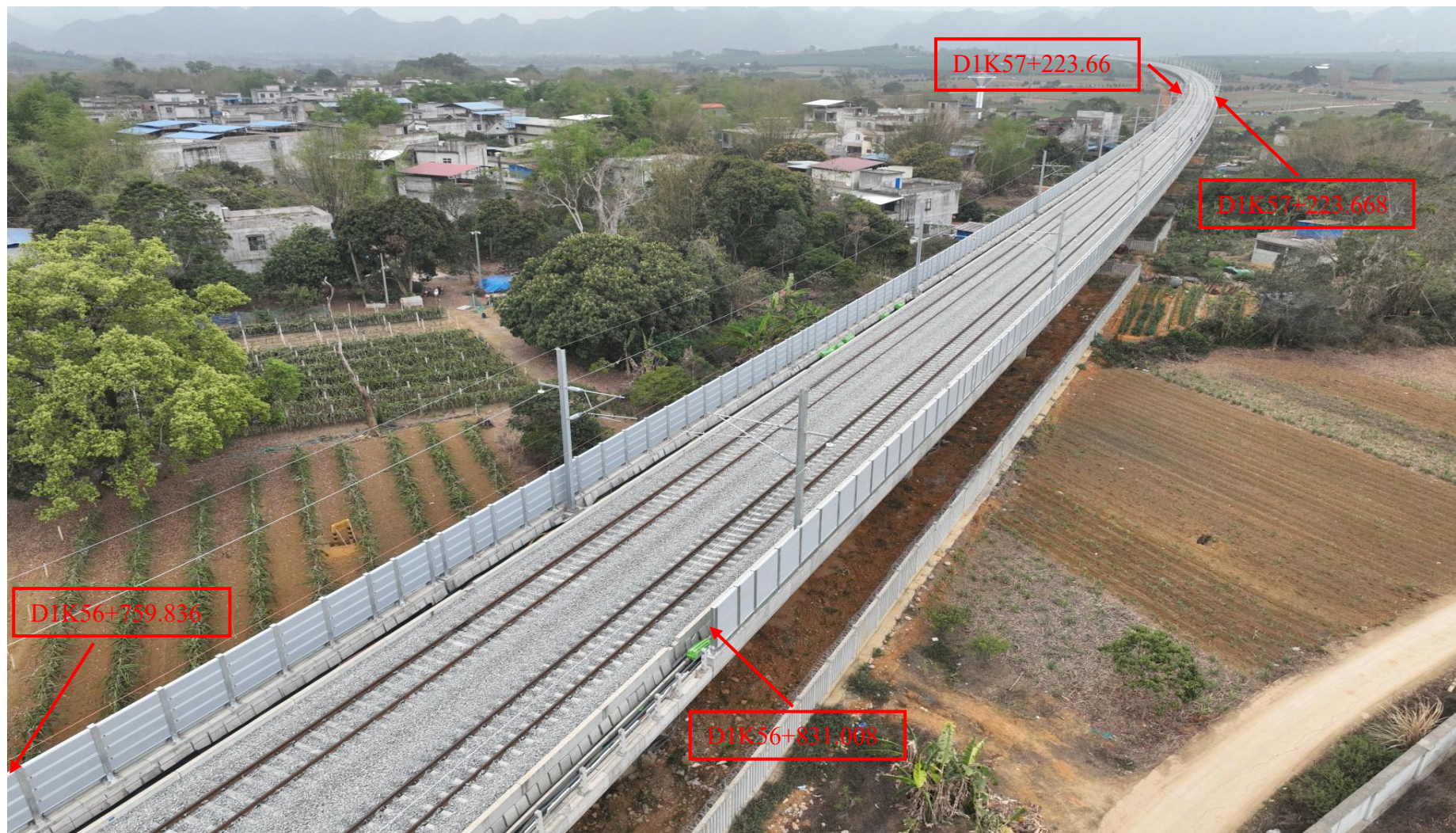
图 6.3-5 (b) 渠皿声屏障现场航拍照片
