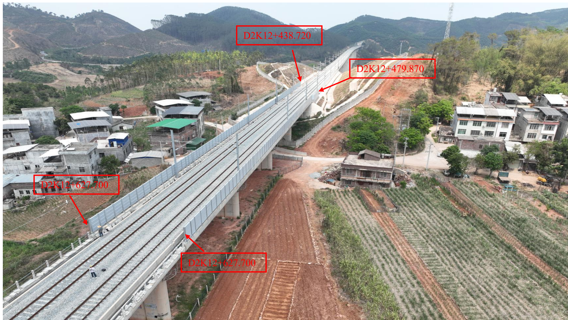
图 6.3-3 (b) 民族新村（环评为停达）两侧声屏障现场航拍照片
