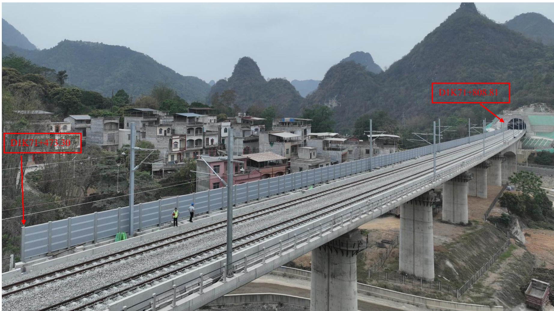
图 6.3-6 (b) 扣步声屏障现场航拍照片
