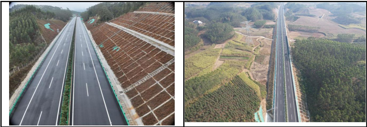
图 2.3-3 典型路堤、路堑路段路基、路面、边坡防护和排水现状
