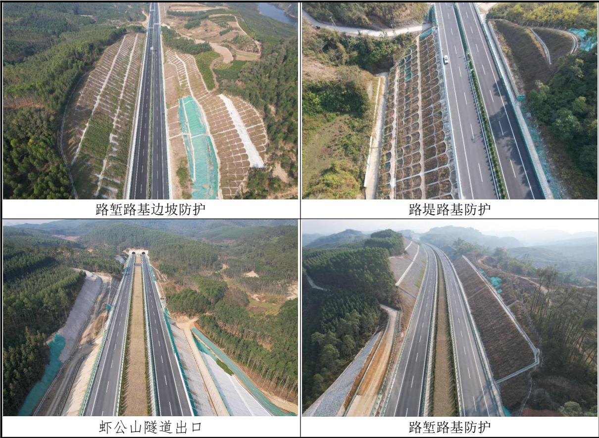
图 5.3-4 本项目典型边坡防护现场图片
