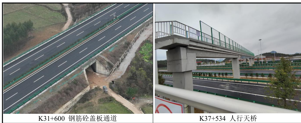
图 2.3-8 通道、天桥现状
