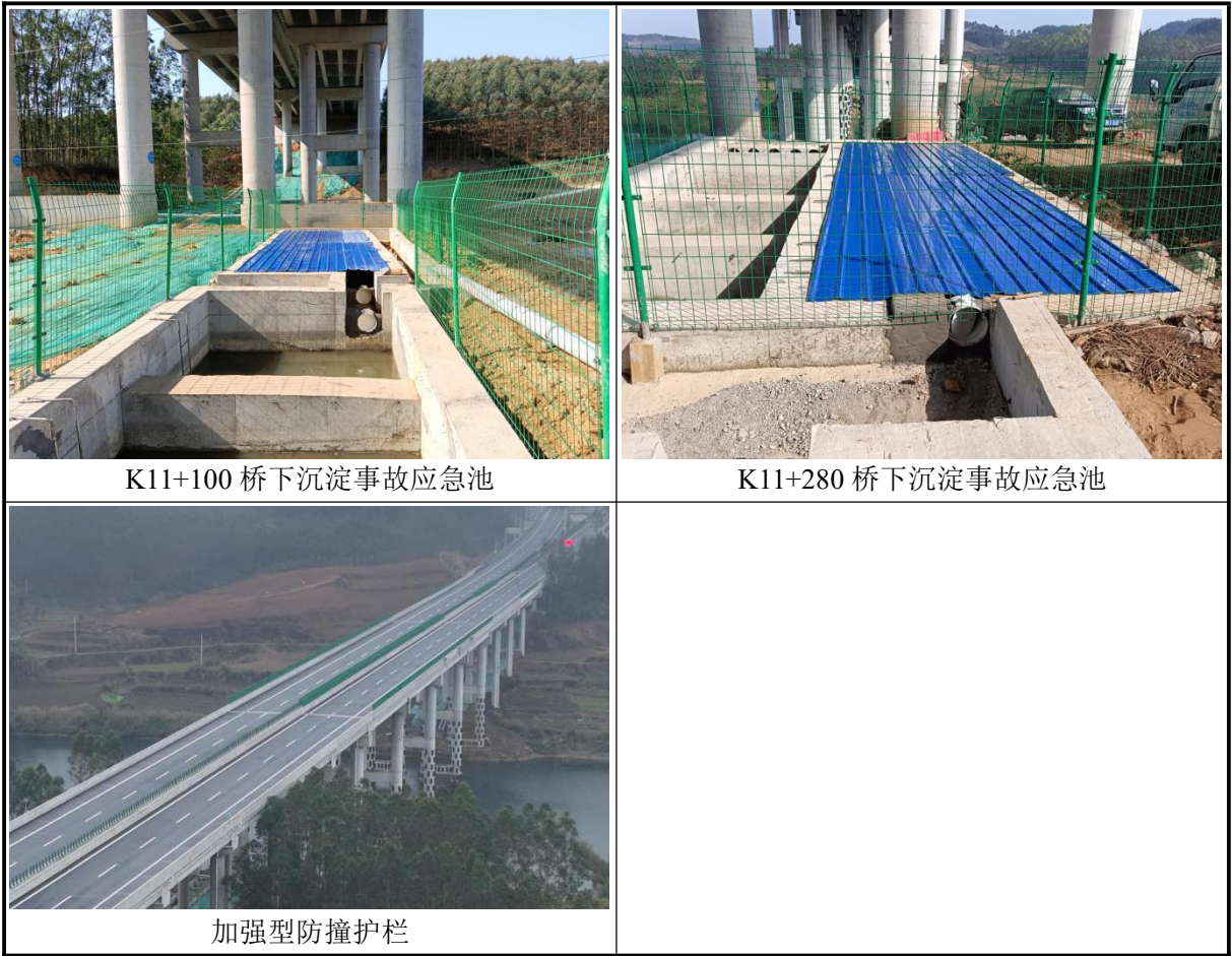
图 8.5-2 跨越龙江河路段风险防范措施现状
