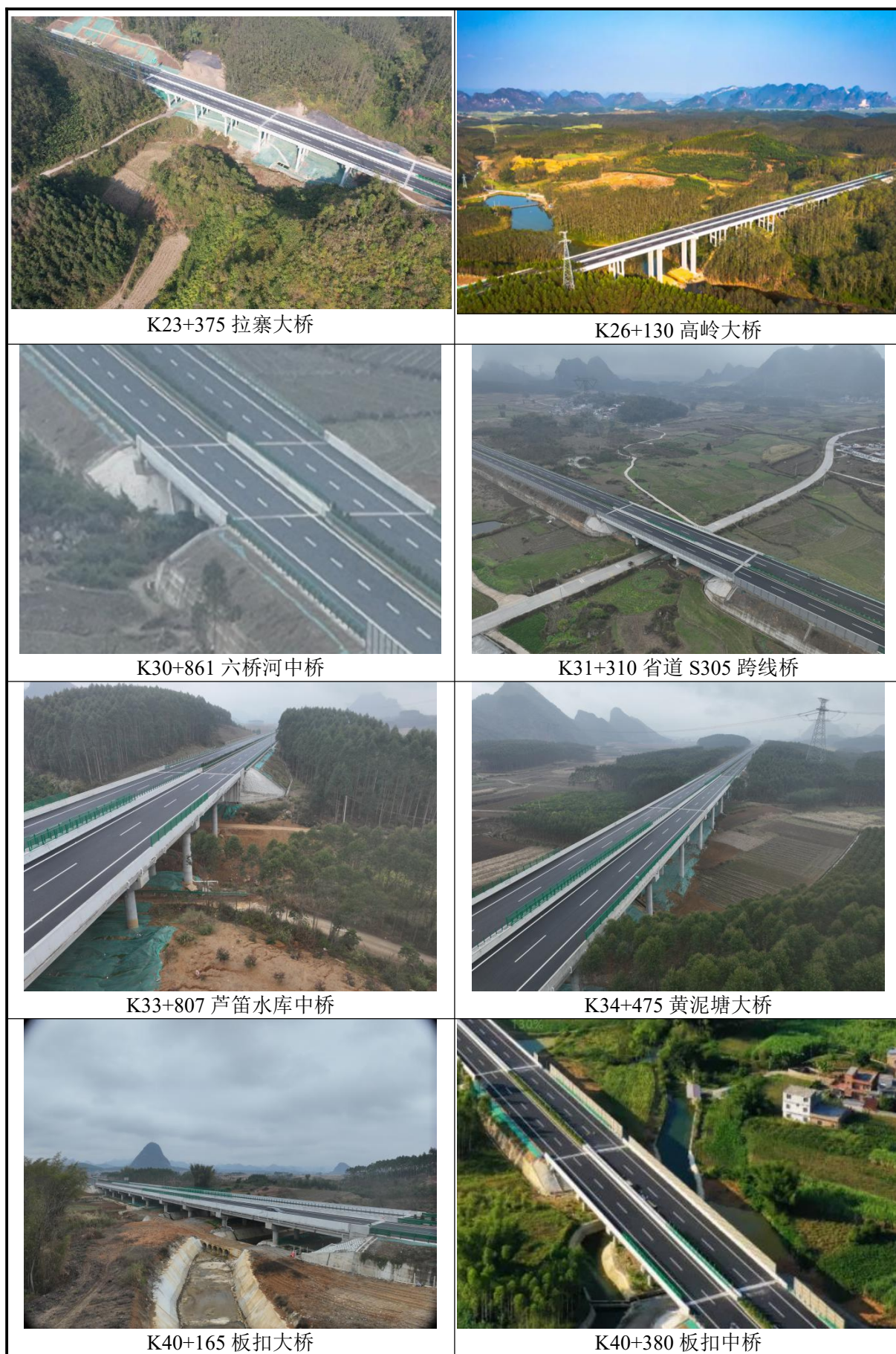
图 2.3-4 桥梁现状照片
