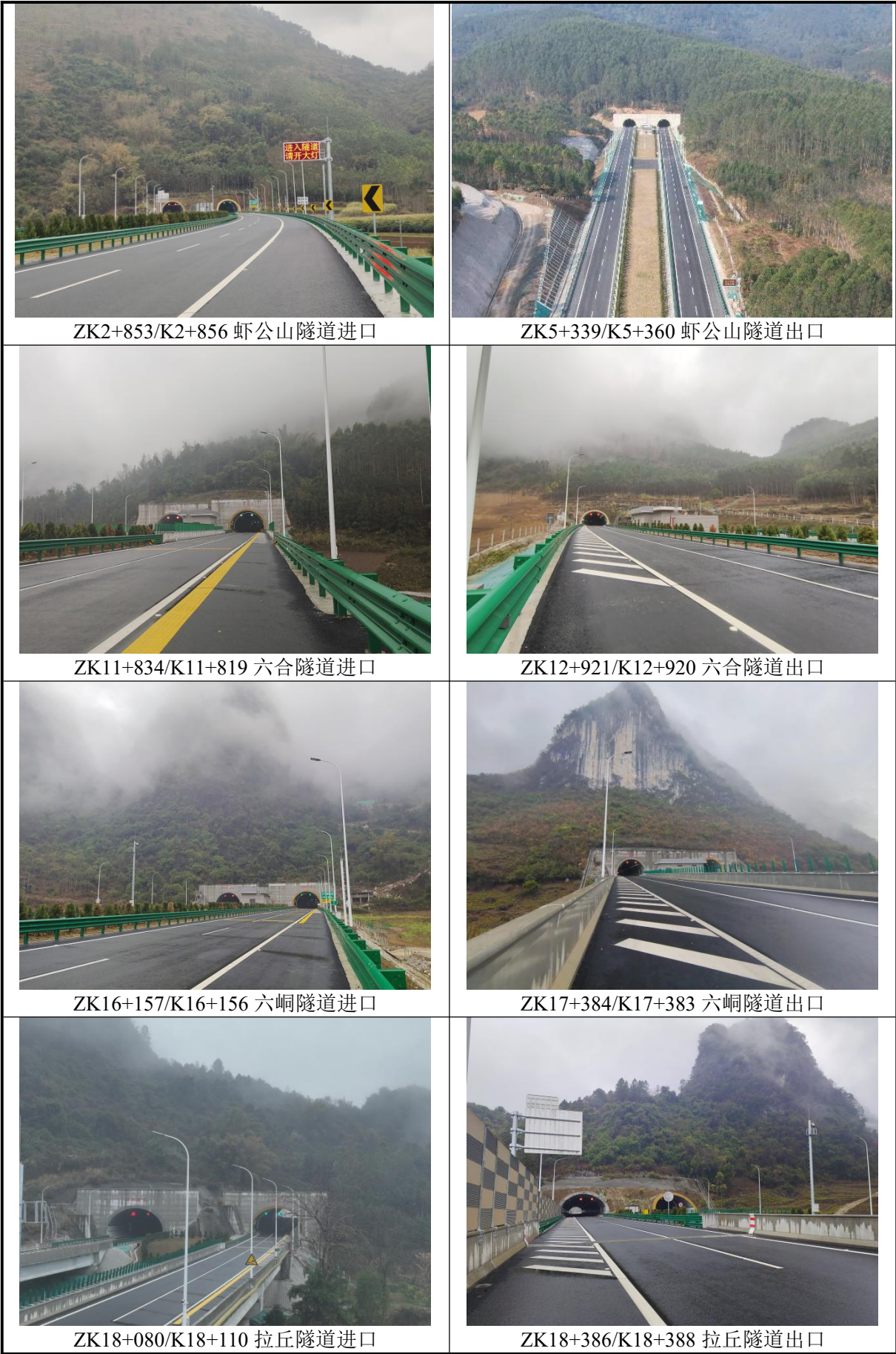
图 2.3-6 隧道口现状照片
