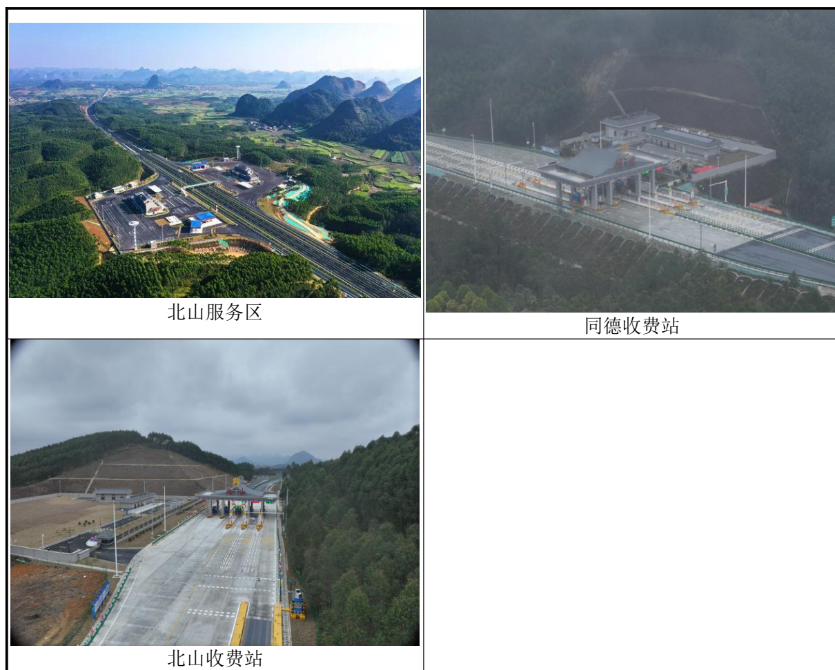
图 2.3-9 沿线设施现状
