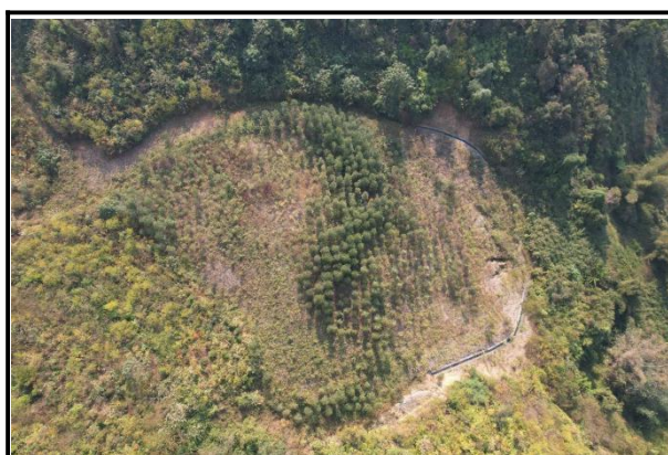
K23+550 右侧弃渣场
