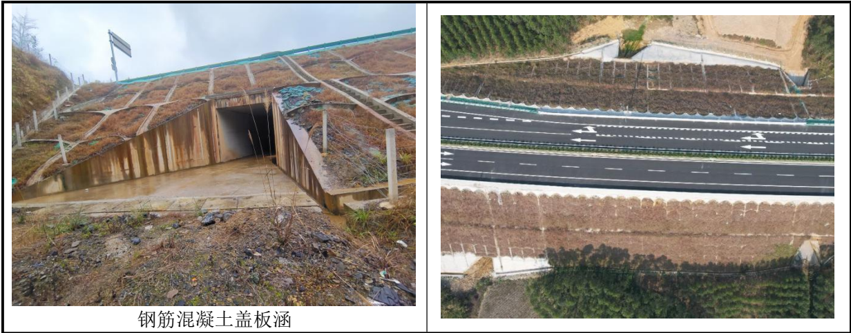
图 2.3-5 涵洞现状照片
