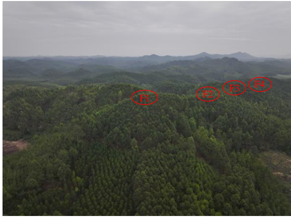
F1-F4 风机现状照片
