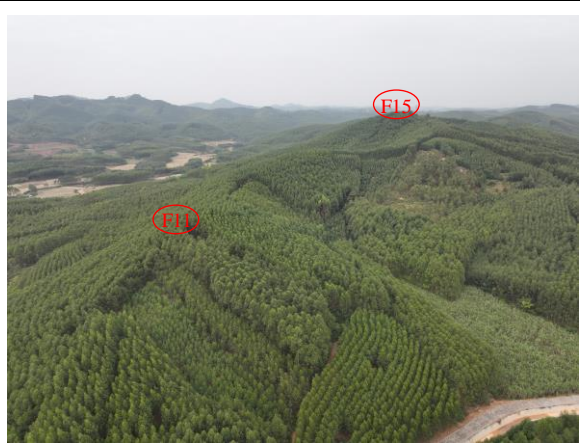
F11、F15 风机现状照片
