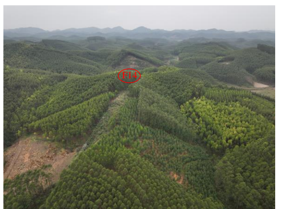
F14（备用）风机现状照片
