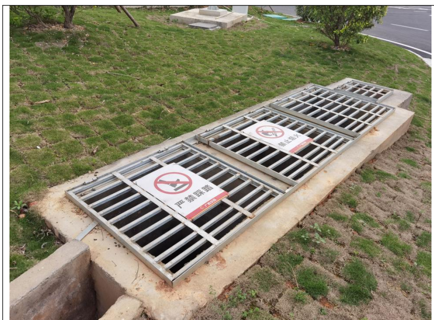
服务区加油站隔油池
