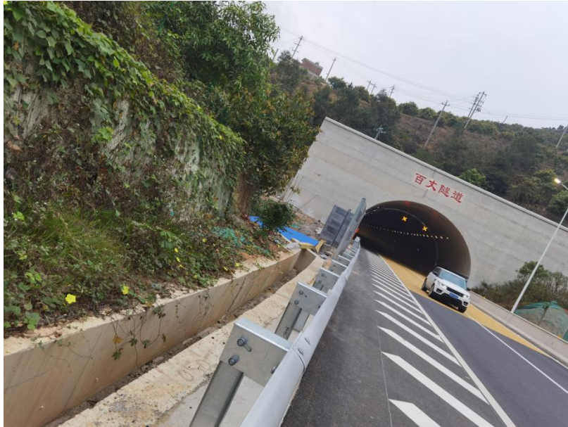
图 8.5-2 沿线排水沟渠及油水分离池
