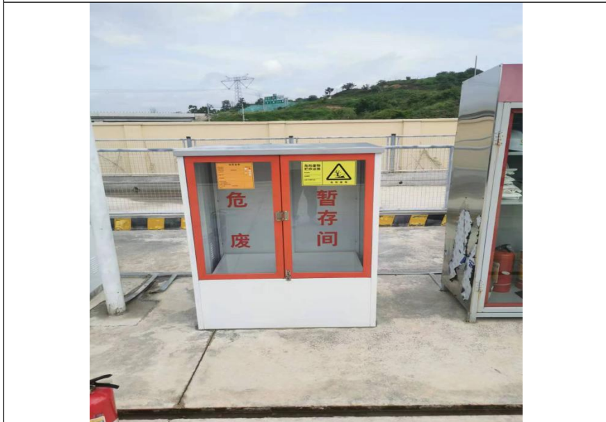
林逢服务区加油站危废暂存柜
