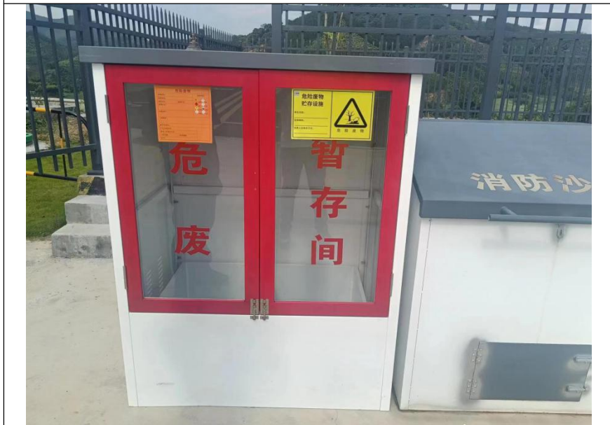
义圩服务区加油站危废暂存柜
