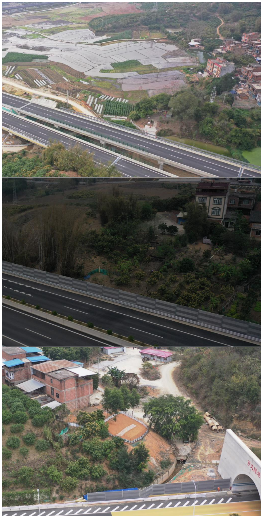
图 7.3-1 沿线典型声屏障照片
