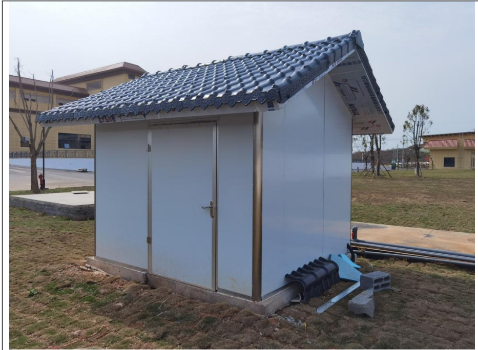
林逢服务区污水处理站设备间
