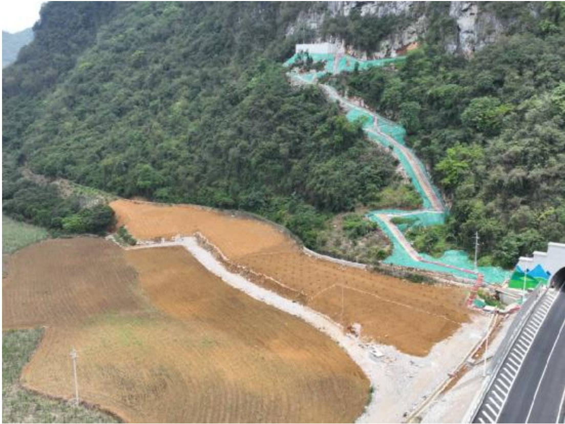
K168+000 左侧内市隧道驻地，覆土平整，撒播草籽，现复耕
