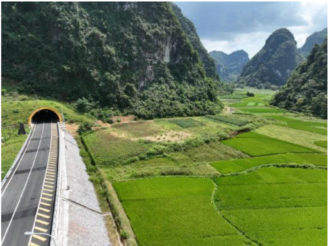
K142+000 左表土堆放场，撒播草籽，现复耕
