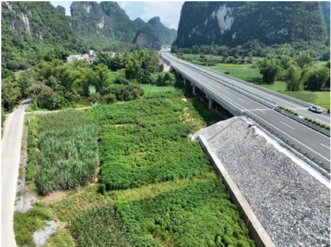
K147+111 向水河大桥
