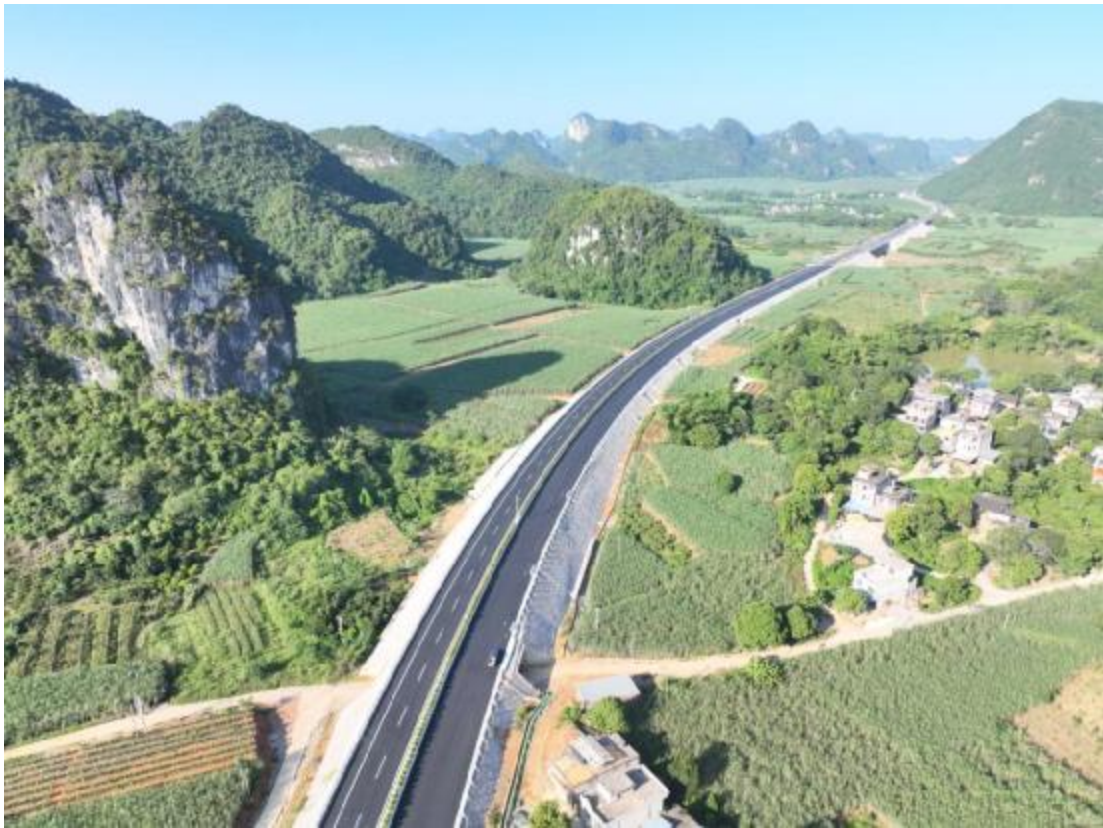
K241+7000 路基填石边坡
