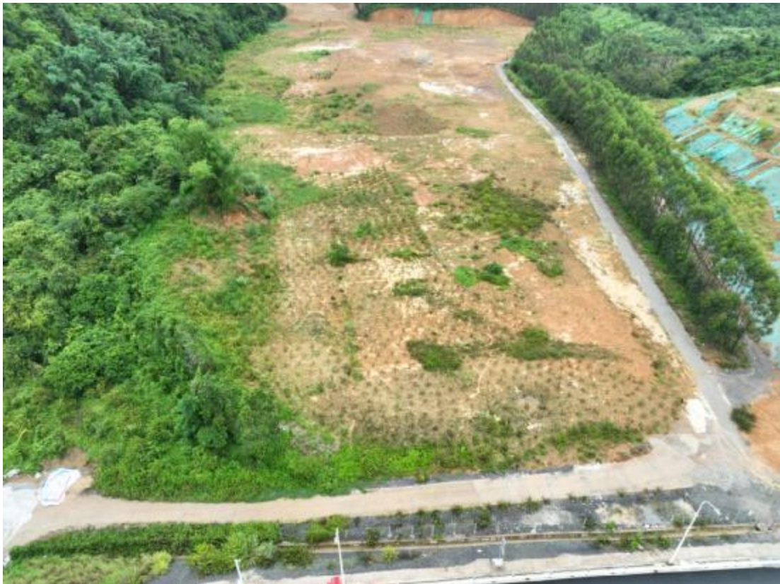
K277+000 右侧 150 米板角隧道综合场站，撒播草籽，村民植树
