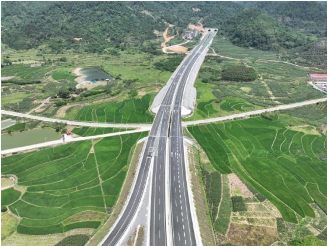
K276+100 段填石路基
