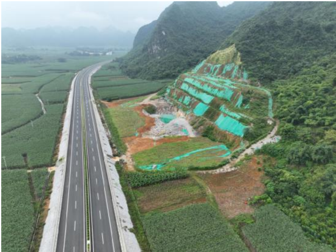
K257+000 路基取石（红线内），边坡分级，客土喷播，底部用于连接线工程场站建筑垃圾回填
