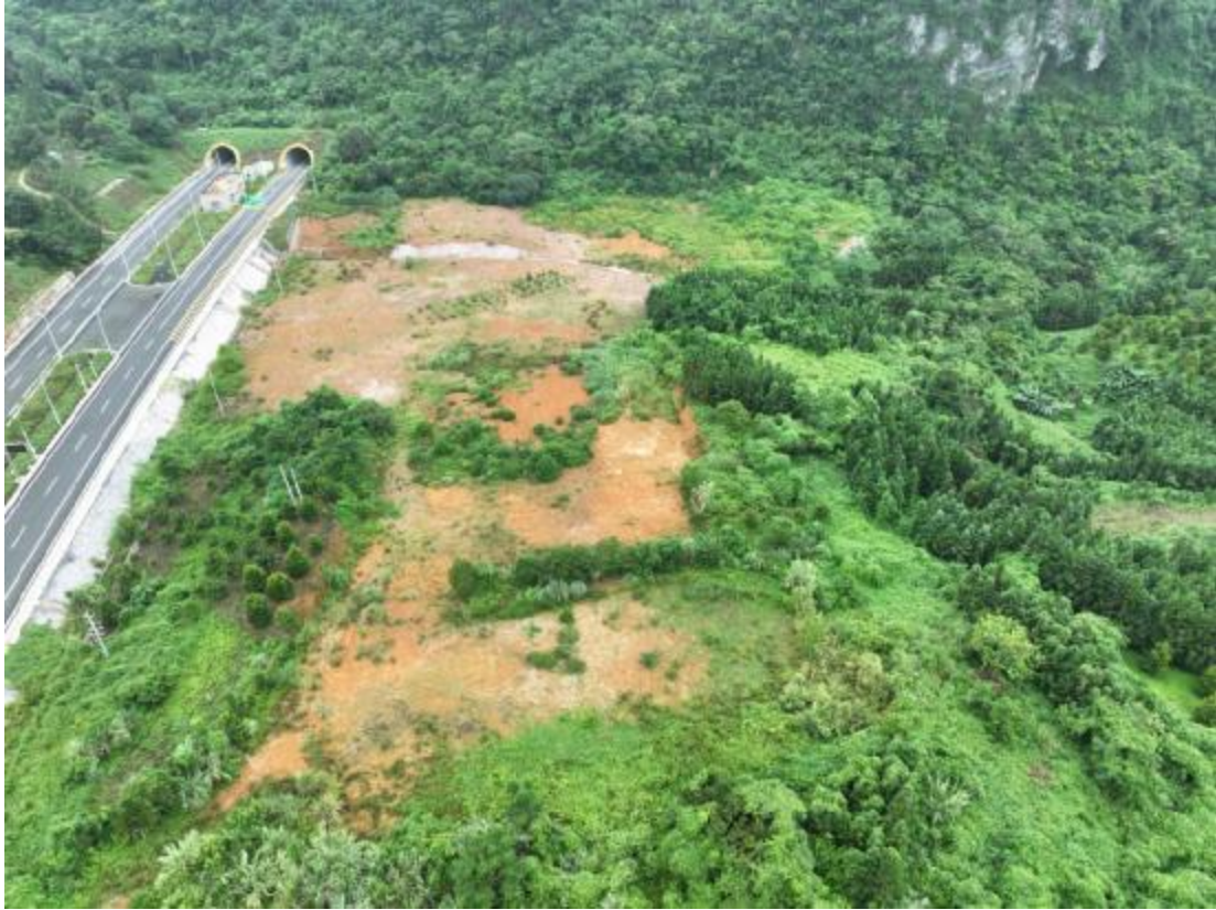
K270+300 岗龙坳出口左幅工区，覆土平整，复耕
