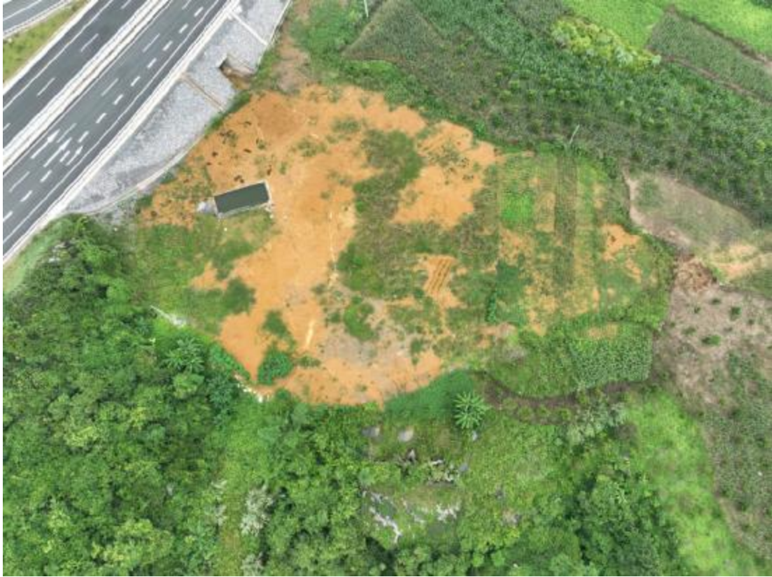
K276+940 右路面拌合站
