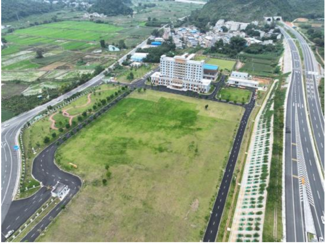
K155+300 大新北互通骨架护坡，排水沟，景观绿化
