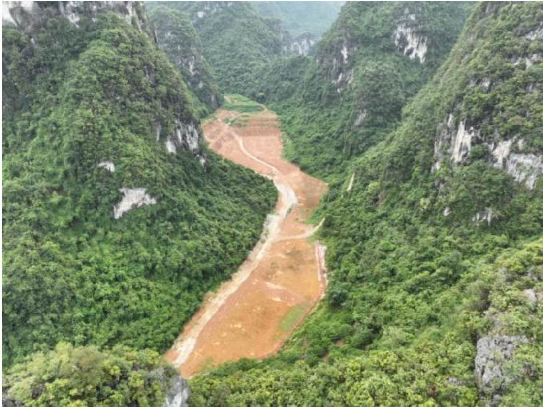
K229+300 左侧 250m 4 标 3 工区混凝土拌合站，撒播草籽，现复耕
