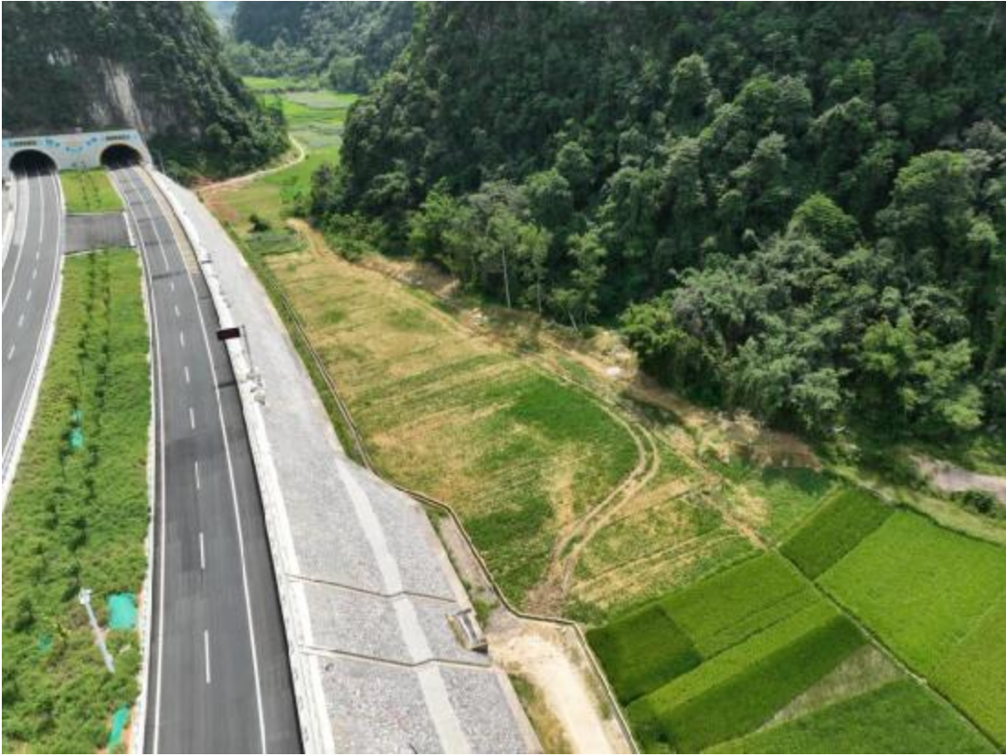
K140+650 右表土堆放场，植草防护，复耕
