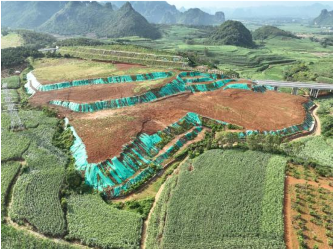
边坡分级植草灌，坡脚挡渣墙，主线截排水沟，复耕
