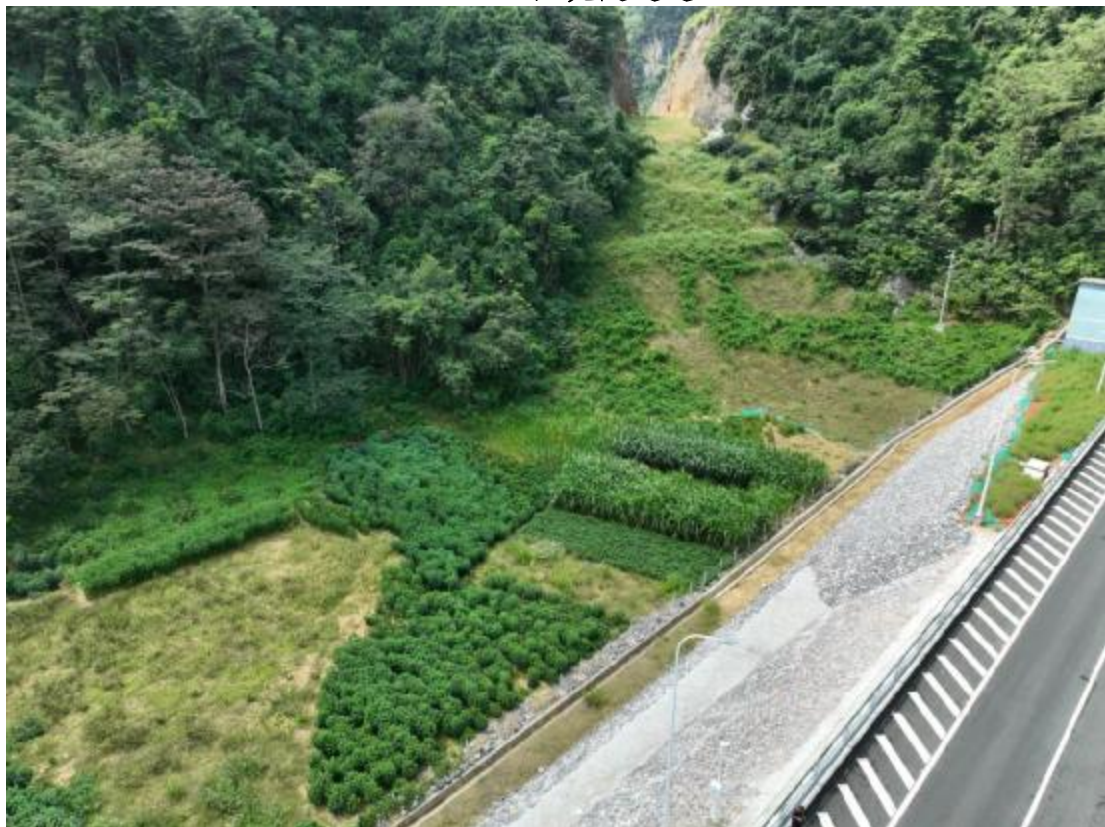
K141+430 康桥隧道便道覆土，撒播草灌、复耕
