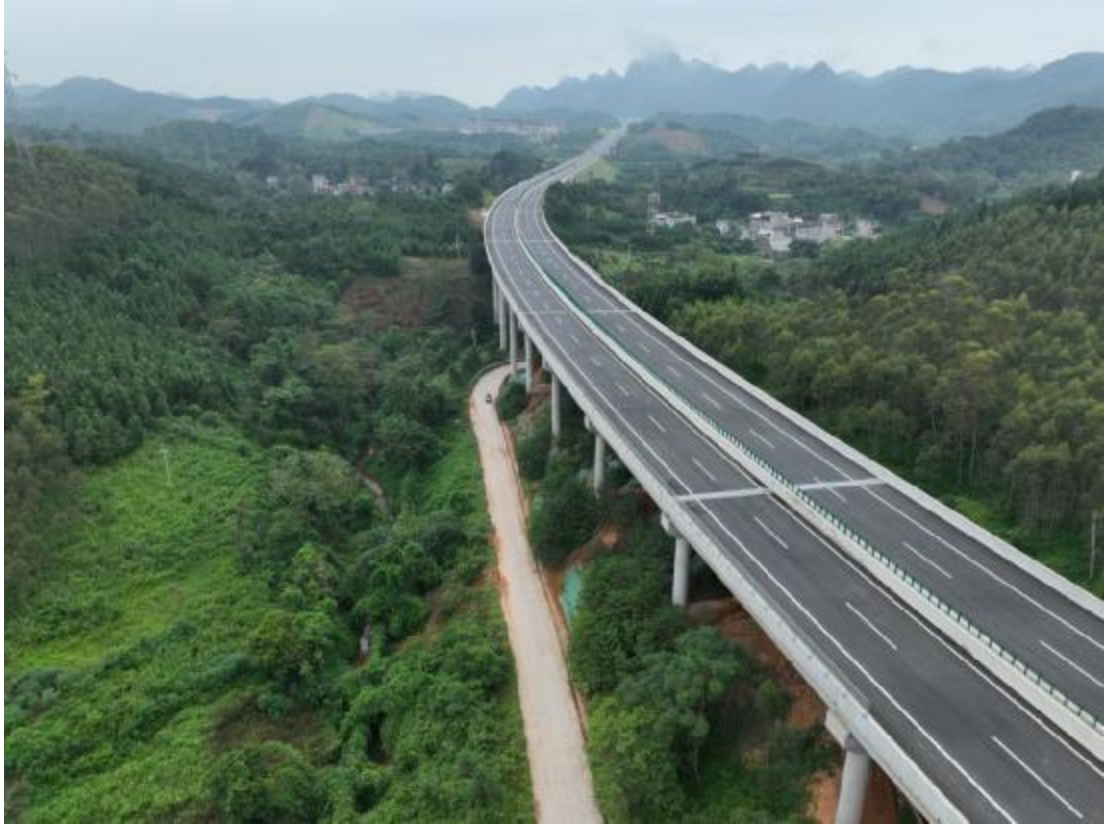
K268+172 下茶 2 号大桥，撒播草籽
