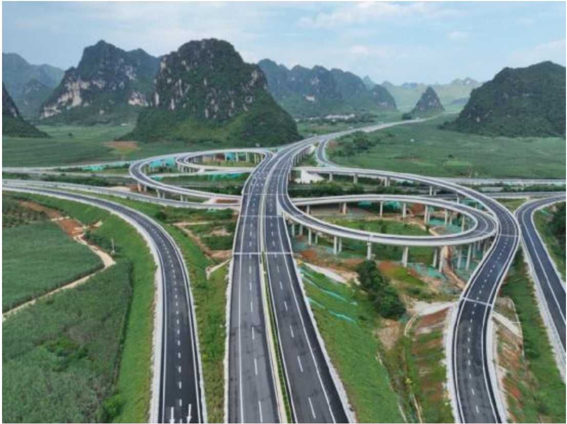
K192+300 三伦互通，骨架植草护坡，景观绿化
