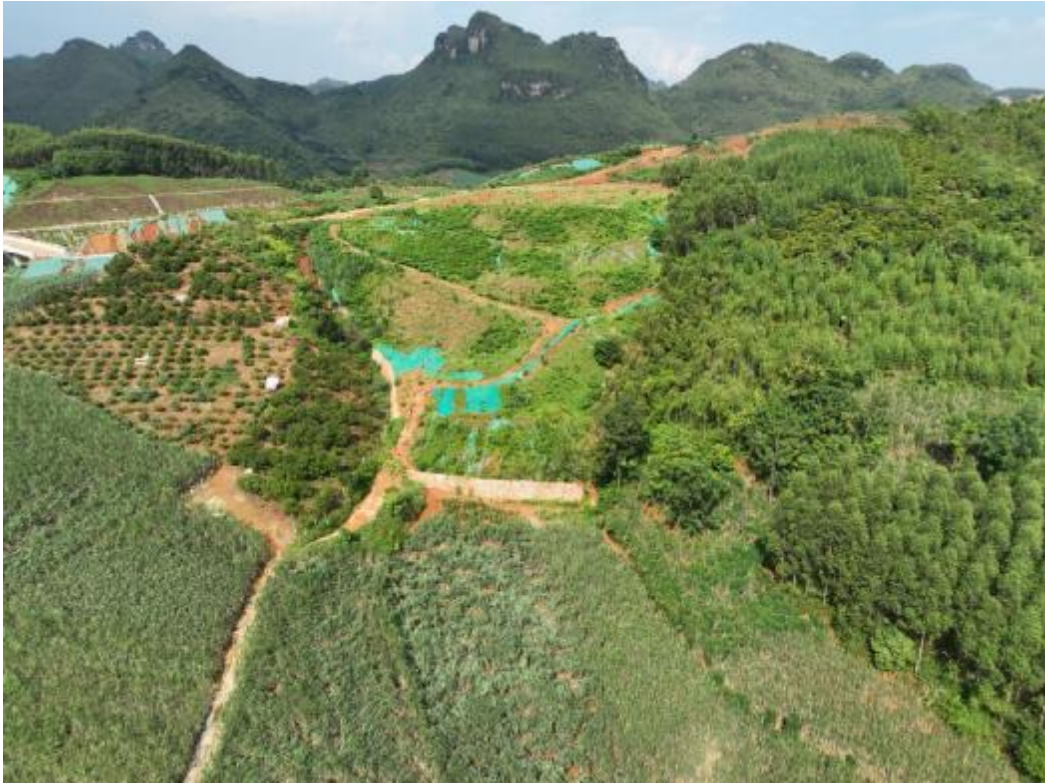
边坡分级植草灌，坡脚挡渣墙，截排水沉沙设施
