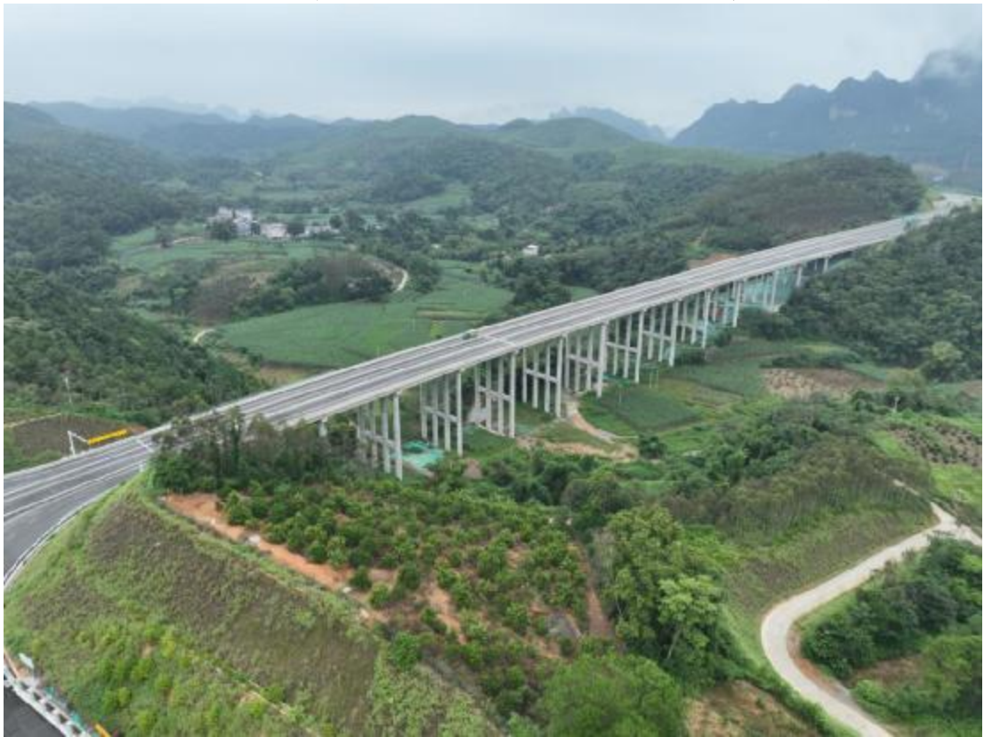
K266+422 安民 3 号大桥，桥底撒播草籽加铺密目网
