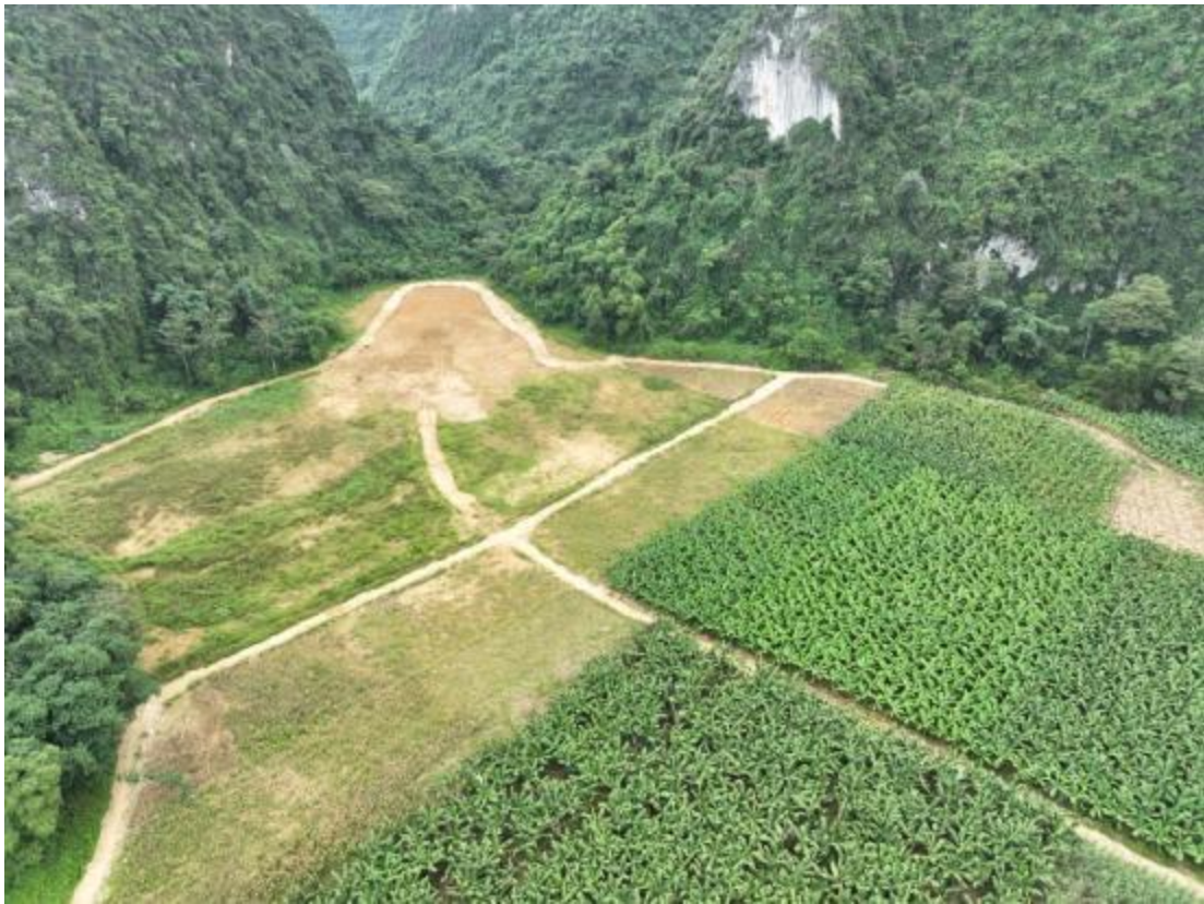
K219+900 左侧 150m 4 标 1 工区混凝土拌合站，覆土平整，撒播草籽，现复耕
