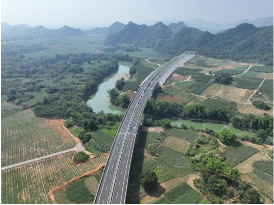
K251+590 水口河大桥
