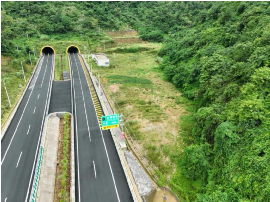
K280+200 右板增隧道驻地，撒播草籽，现复耕
