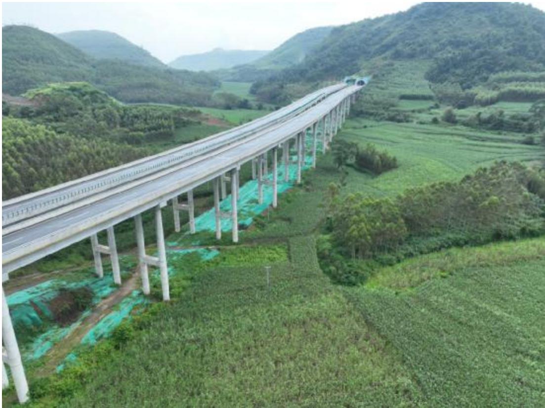
K175+350 反屯大桥，桥下撒播草籽加铺密目网
