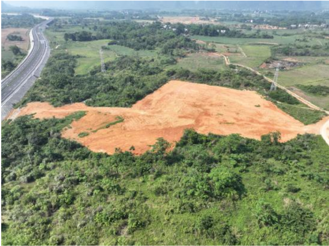
K247+900 右侧 150 米五标 1 号站，复耕，地方纳入旱改水
