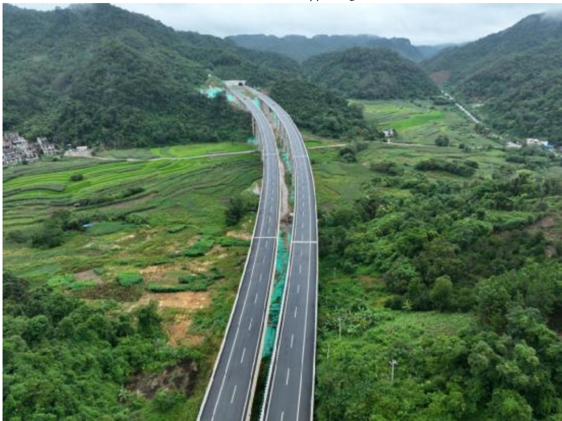
K279+400 板增大桥迹地绿化
