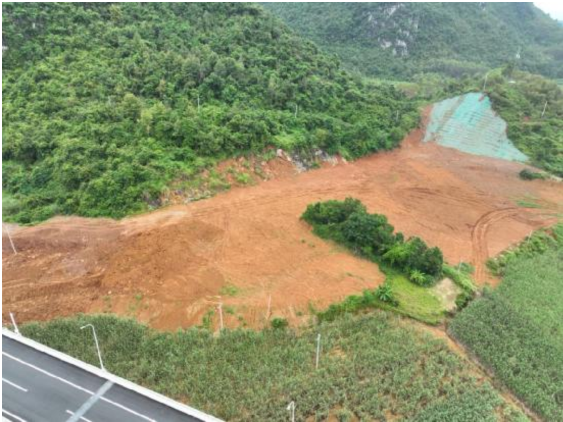
K173+400 左侧 2 标综合场站，边坡草灌，平台复耕
