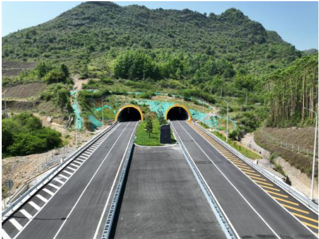
K282+800 界牌隧道出口
