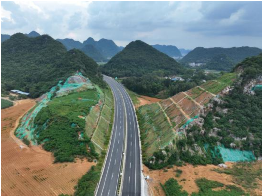
K152+300 左侧边坡植草防护
