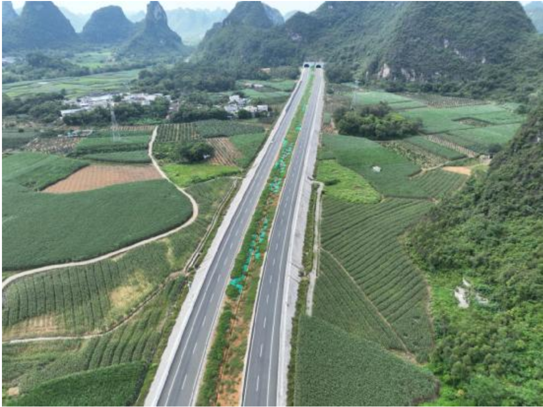
K149+000 山通隧道出口段，覆土，景观绿化
