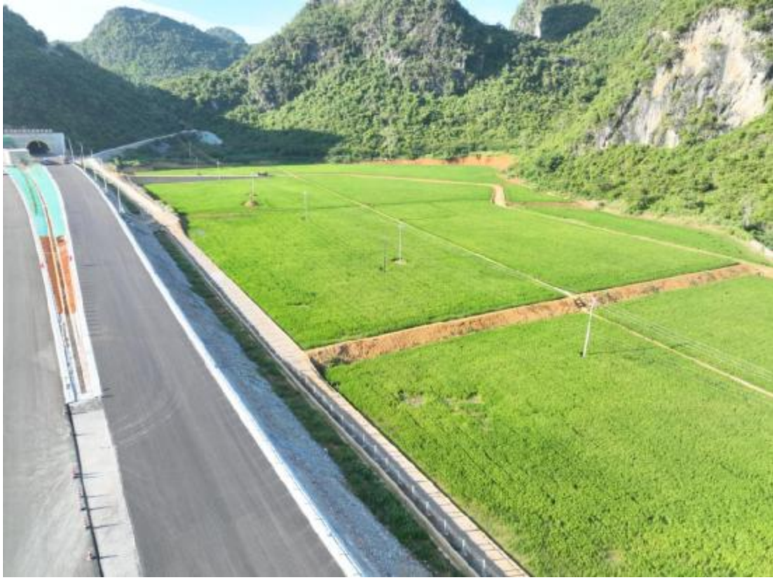
K145+000 左表土堆放场，撒播草籽，现复耕
