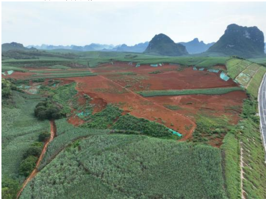
坡脚挡渣墙，边坡分级植草灌，复耕
