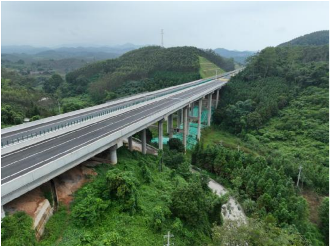
K269+070 那瓦大桥，平整，撒播草籽
