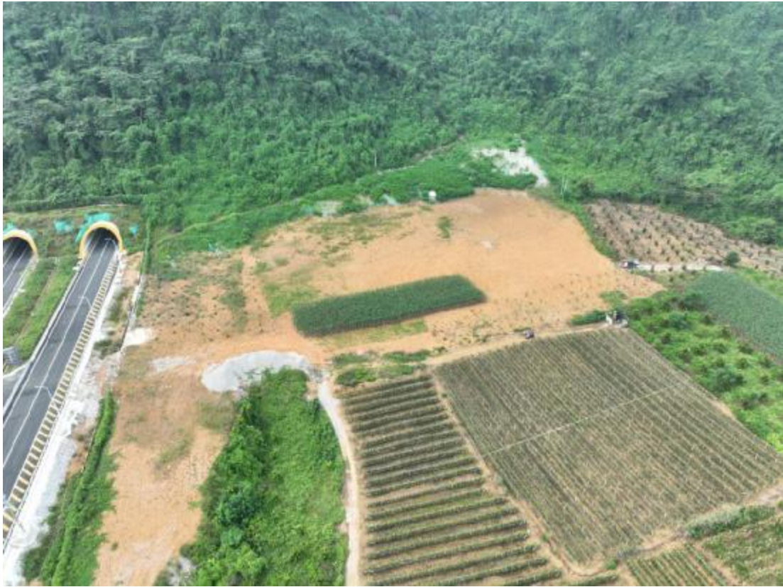
K242+600 痕塘隧道进口右拌合站，覆土平整，撒播草籽，现复耕
