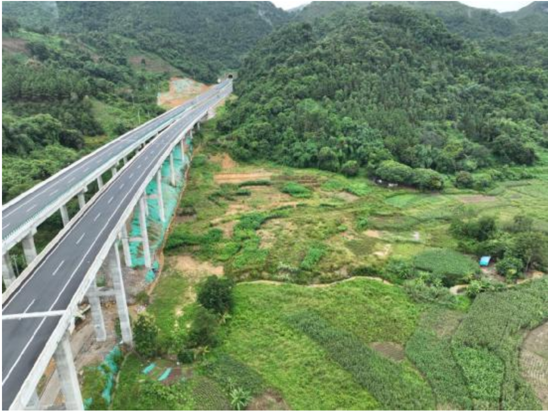
板增隧道湿喷站，撒播草籽，现复耕
