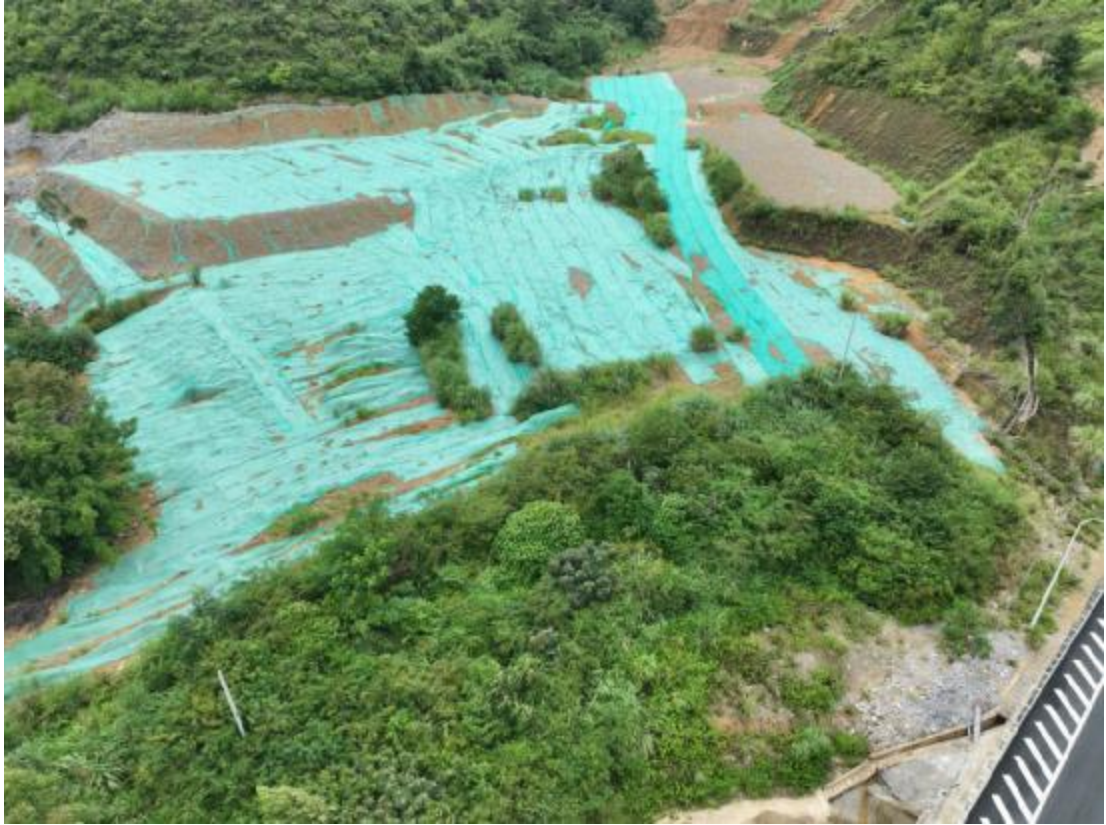
K282+628 右界排隧道驻地，覆土平整，植草防护
