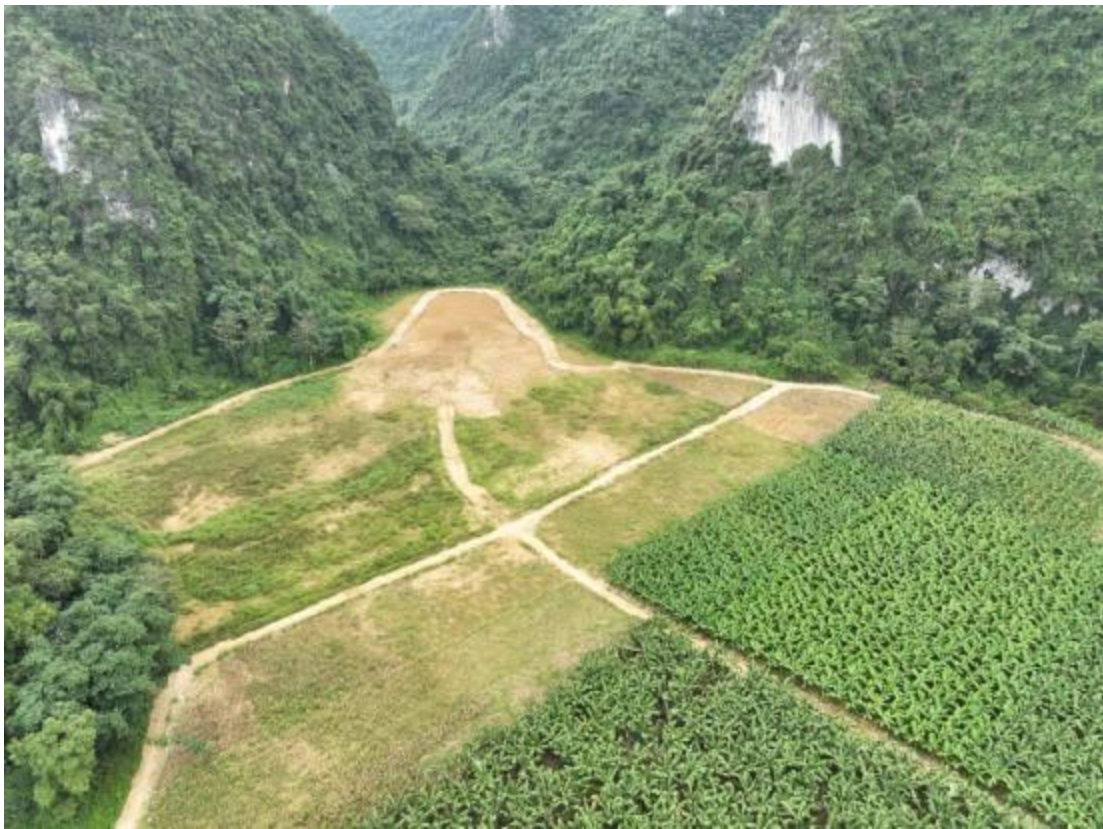
K219+900 左侧 150m 表土堆放场，撒播草籽，现复耕
