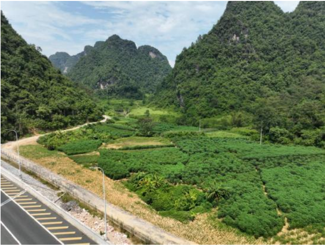
K141+100 右表土堆放场，撒播草籽，现复耕
