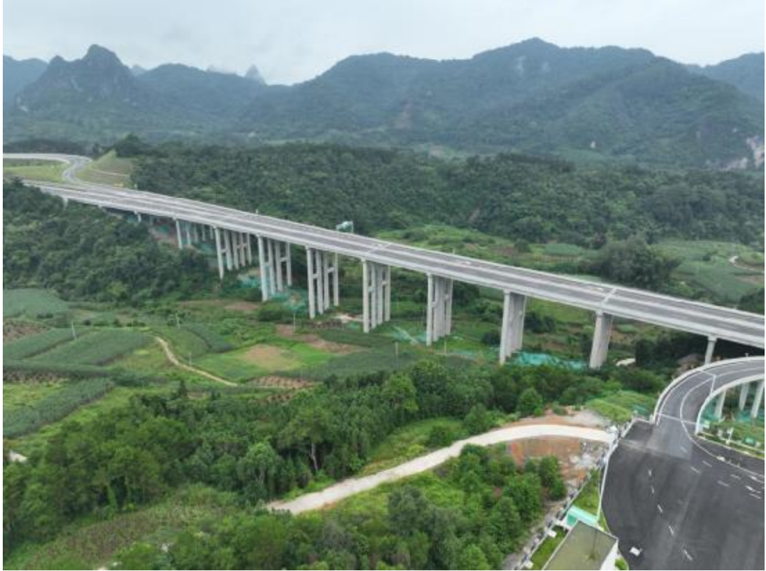
K266+000 龙州南服务区互通立交 A 匝道，桥底撒播草籽加铺密目网
