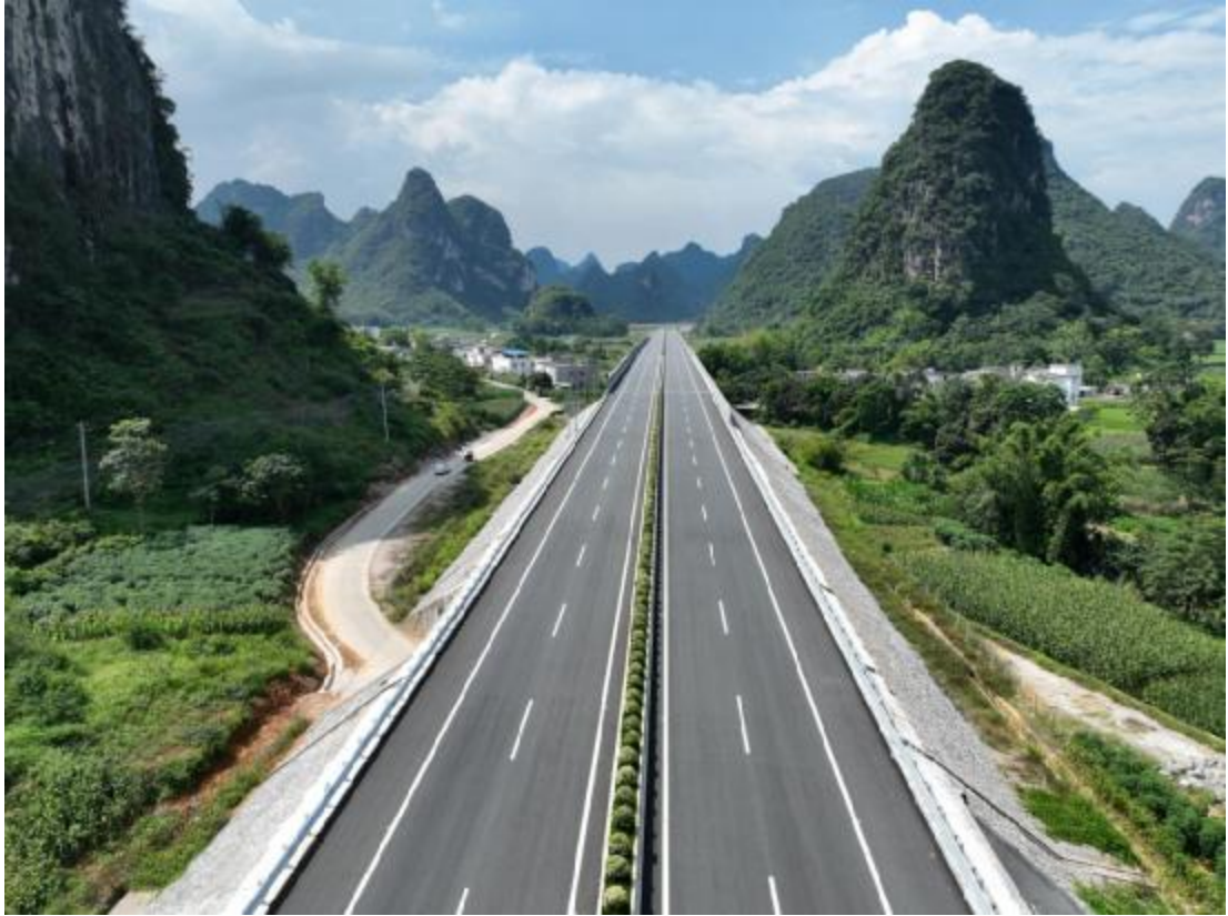
K146+500 路基填石边坡，坡脚排水沟，中央分隔带
