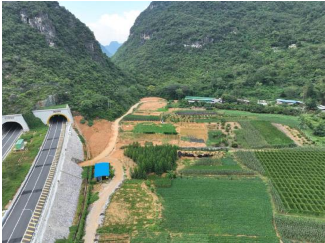
K154+850 马能隧道右钢筋加工厂，覆土,撒播草籽，现复耕。
