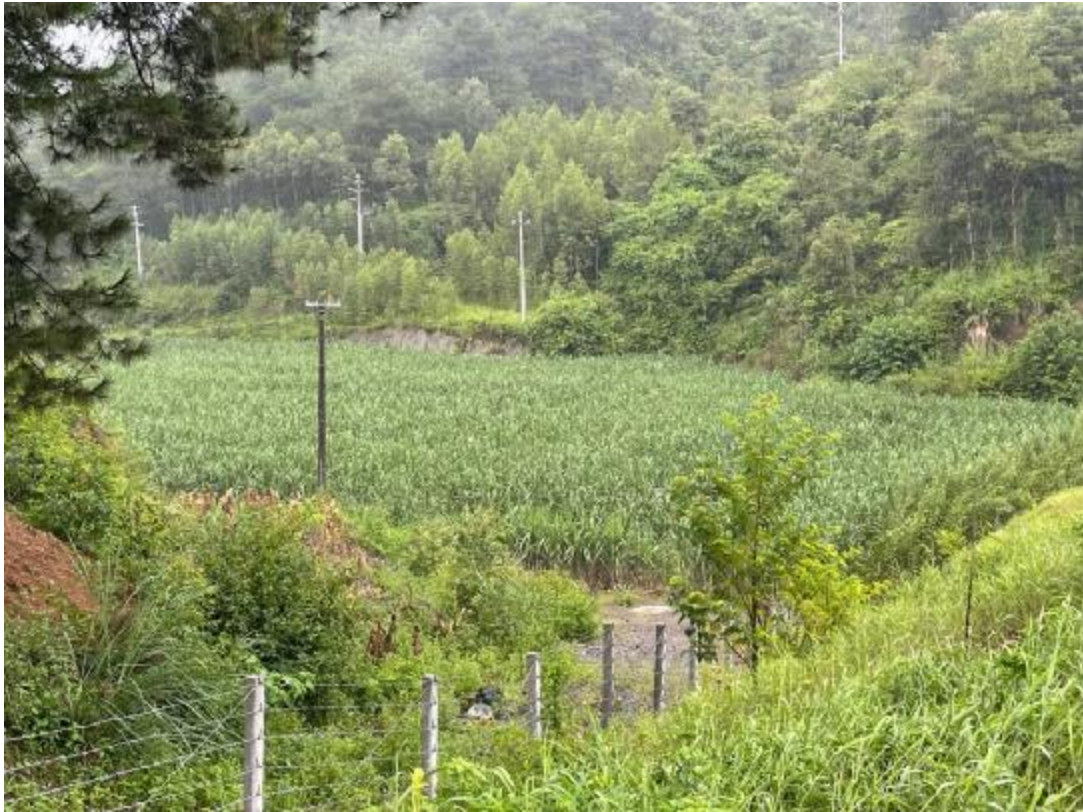
K176+240 曲定隧道出口场站，撒播草籽，现复耕
