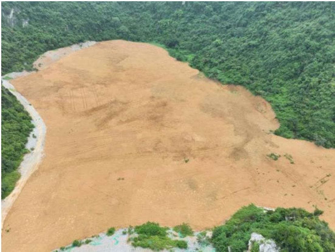
K246+000 左五标碎石场，撒播草籽，复耕，地方纳入旱改水
