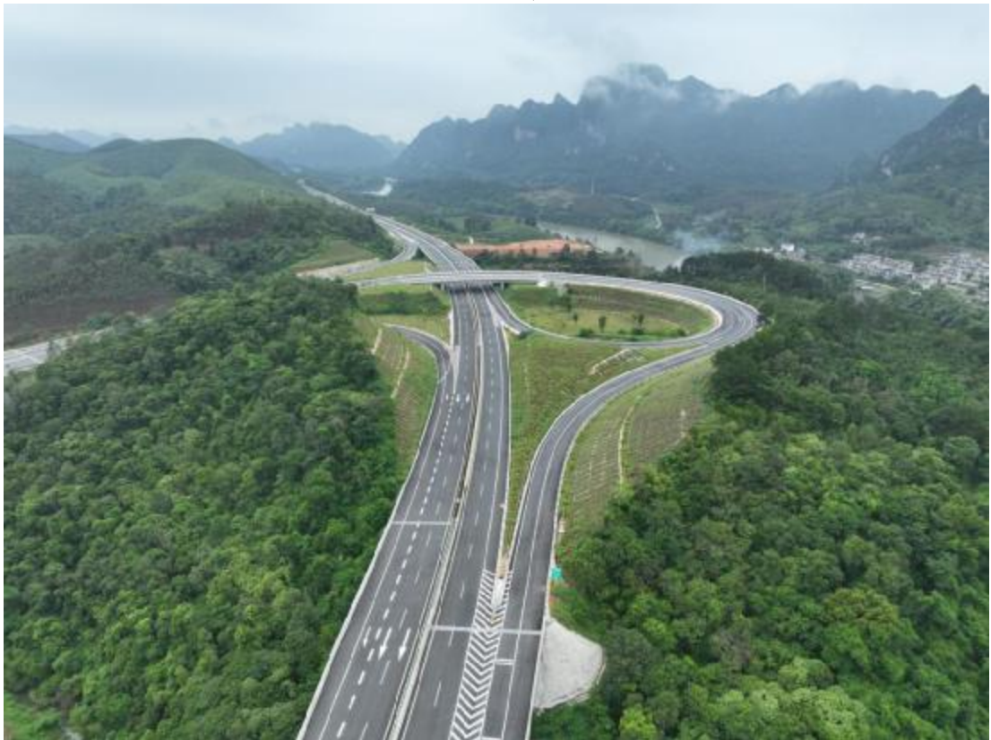
K266+000 龙州南服务区互通立交，骨架植草防护，路基边沟
