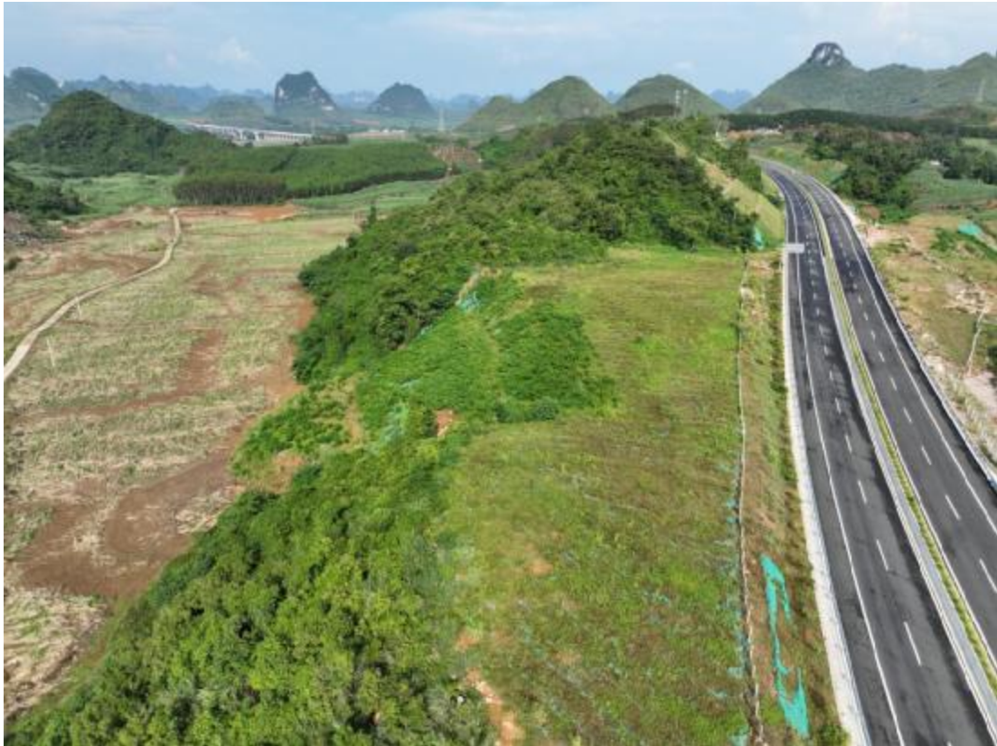
边坡已分级植草灌，主线排水沟
