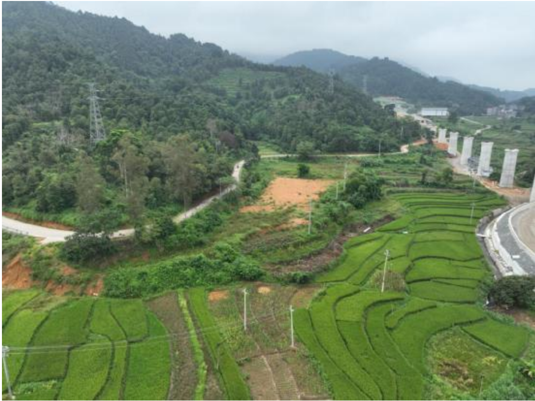
K273+700 右上降隧道入口驻地，覆土平整
