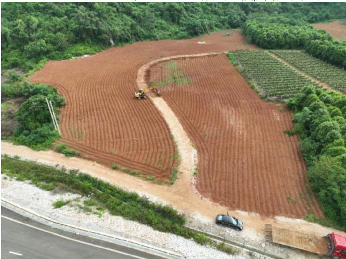
4 标 5 工区混凝土拌合站，撒播草籽，现复耕
