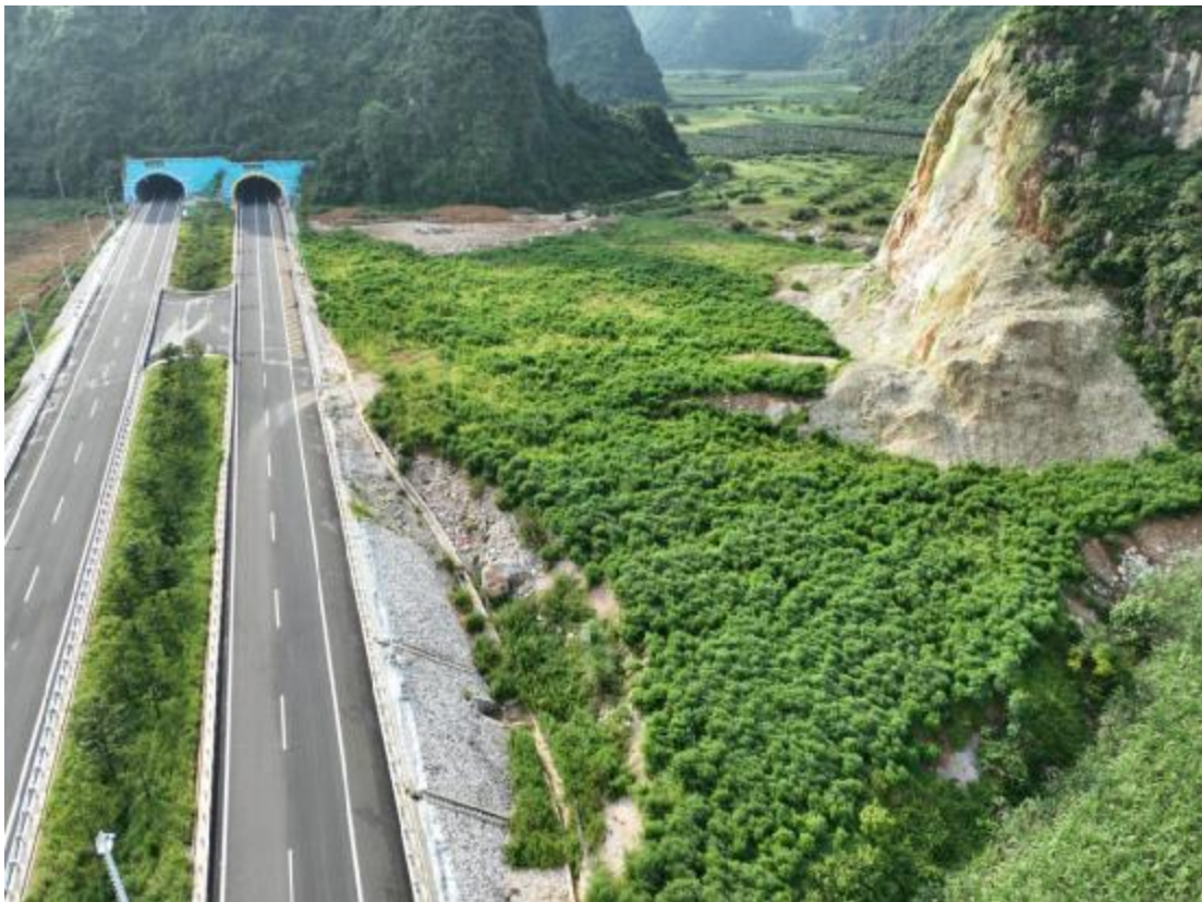
K210+900 逐桐隧道进口段右侧取石（红线内），覆土绿化
