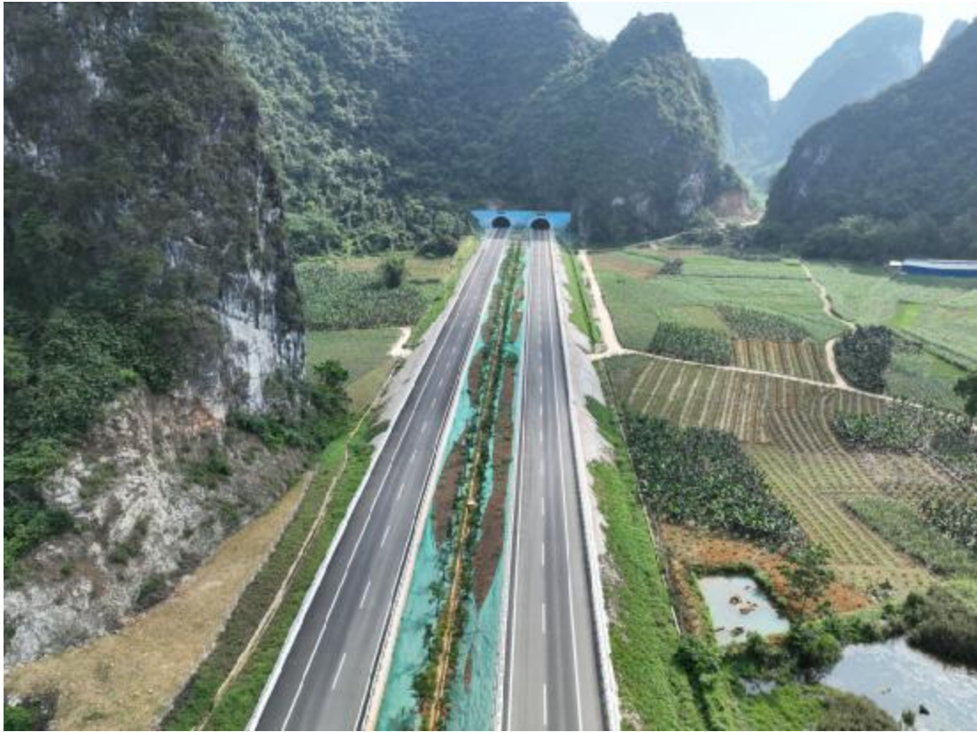
K220+488 伏茶隧道进口段中央分隔带植草、植藤防护
