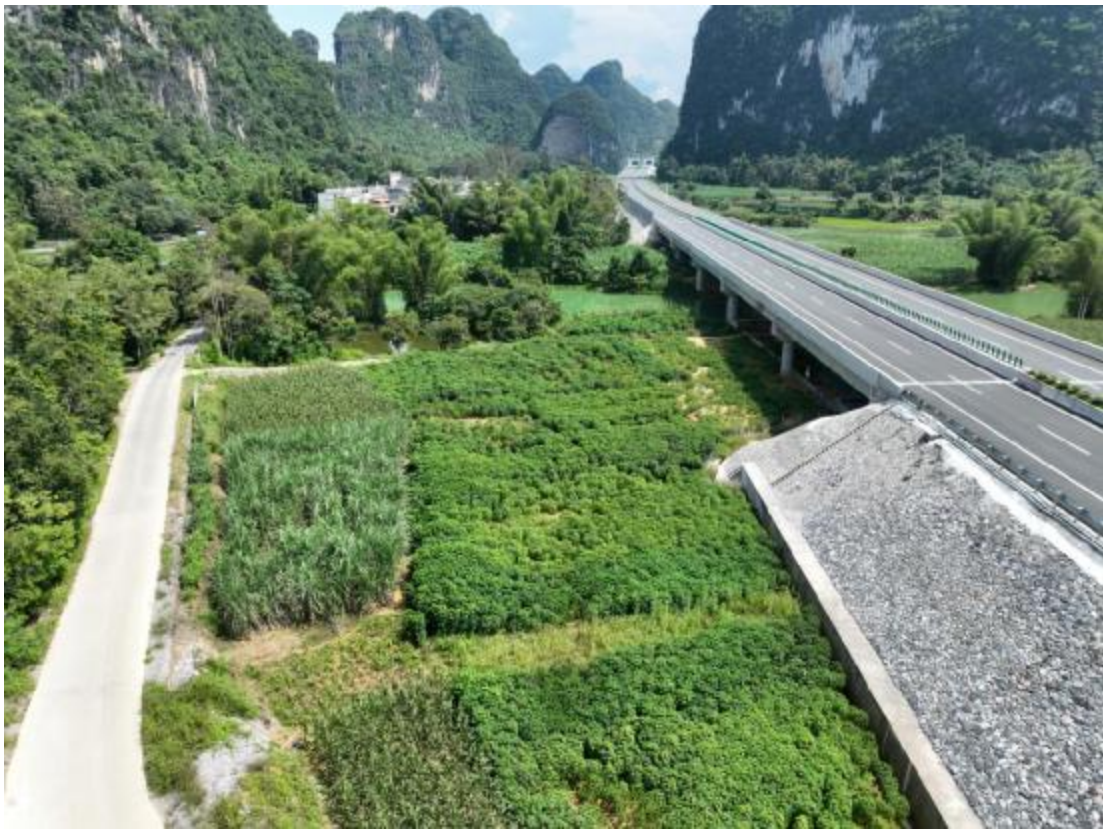
K147+111 左表土堆放场，撒播草籽，现复耕
