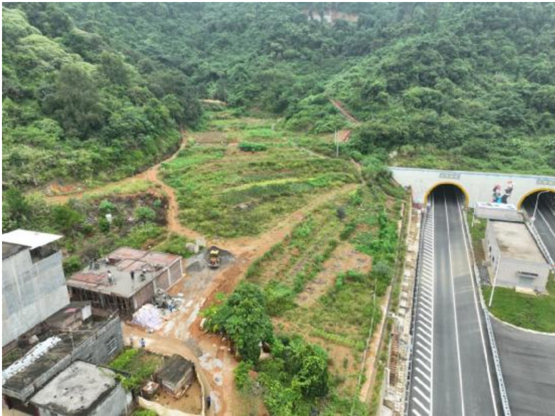
K275+576 上降隧道出口驻地，撒播草籽，现复耕
