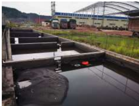
洗车废水沉淀池
