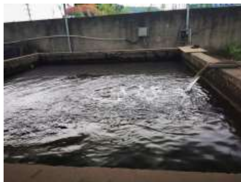
初期雨水干化池
