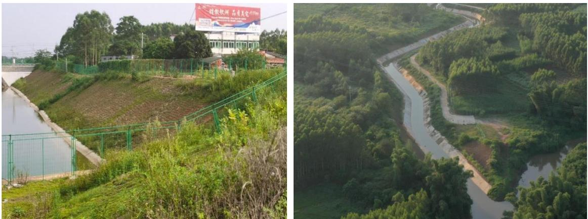
图 5.5-1 本项目典型边坡防护现场图片
