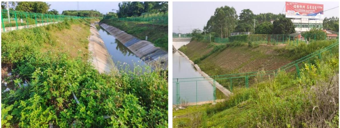
图 5.2-1 主体工程区边坡防护、绿化
