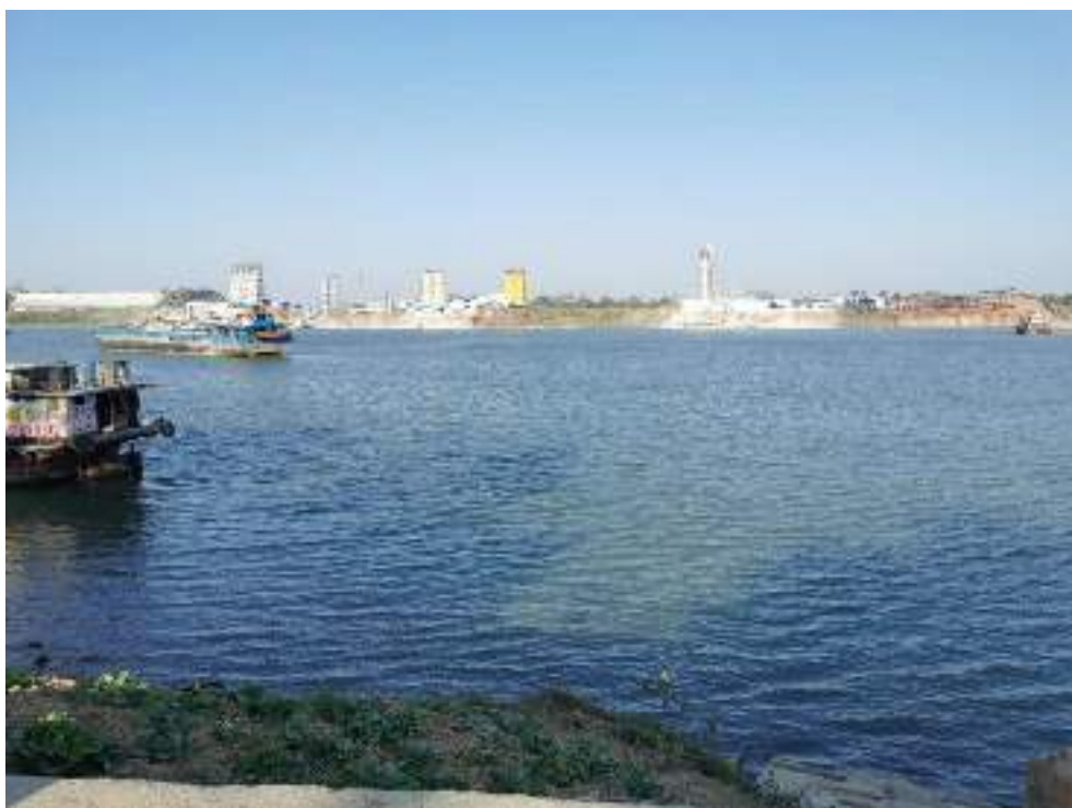
图 2.3-4 路线跨越浔江桥位现场图
