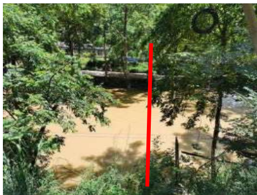
西林连接线跨驮娘江大桥
