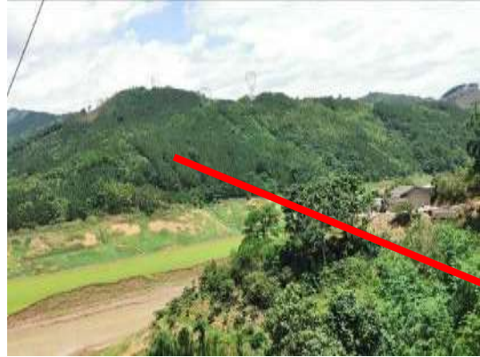
主线终点（南盘江特大桥）
